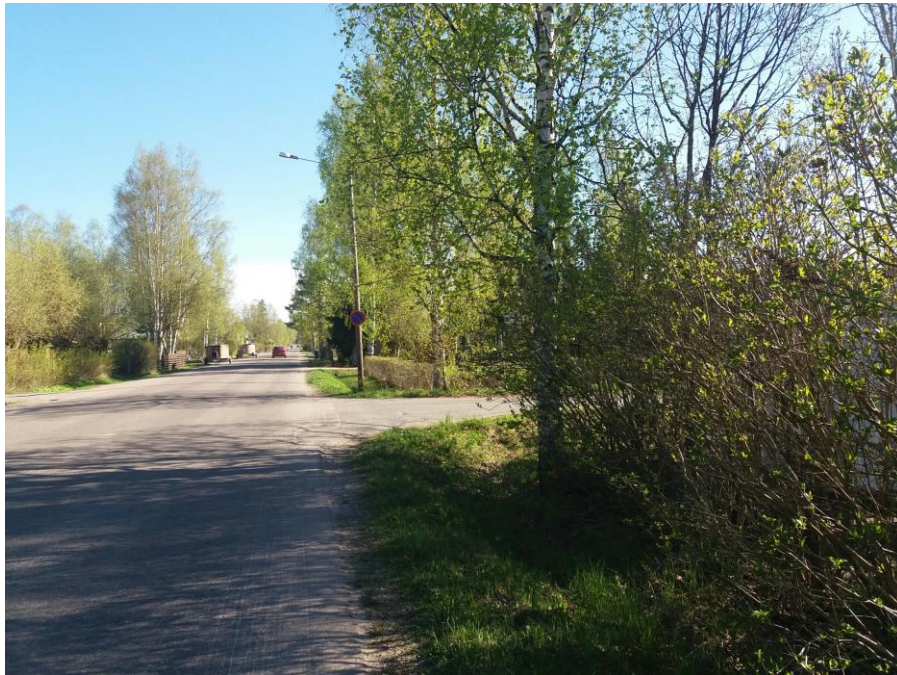
Kuva 16. Ahvenanmaantien liittymä Kytötieltä kuvattuna pohjoiseen päin
