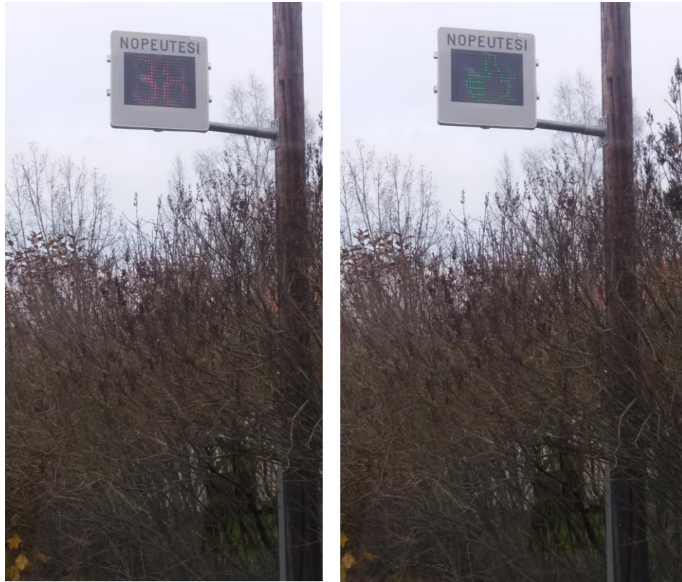
KUVA 19 ja 20. Nopeusmittausta Kytötiellä
