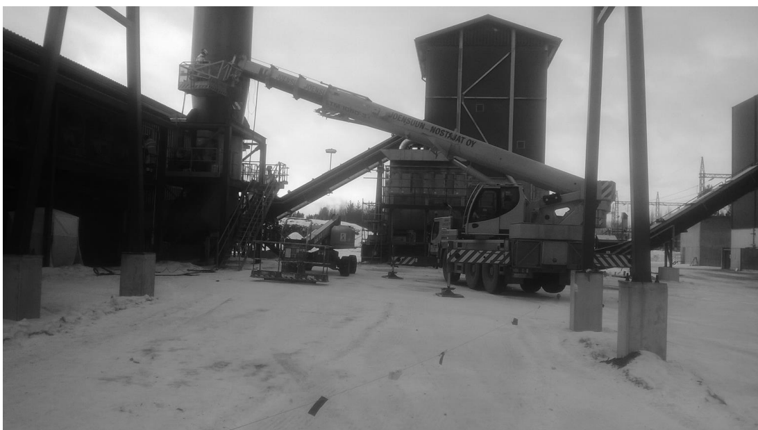
Kuva 6. Poistokaasujen mittaukset tehtiin poistoputkien mittausyhteistä.
