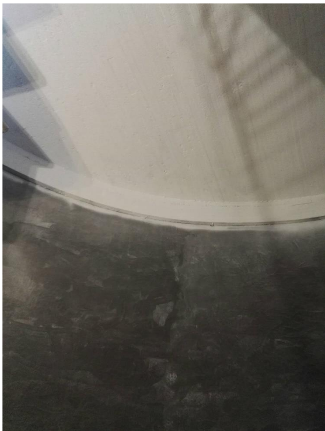
Kuva 10. Katto maalaamisen jälkeen (Pitkänen2017)
