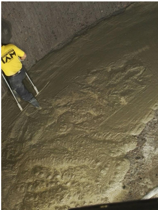
Kuva 8. Lattian betonointi (Pitkänen2017)
