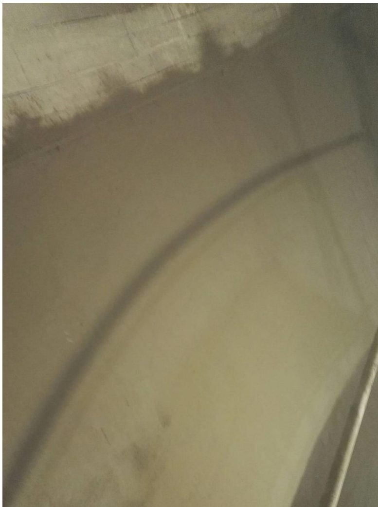
Kuva 5. Säiliön ruiskubetonoinnista (Pitkänen 2017)
