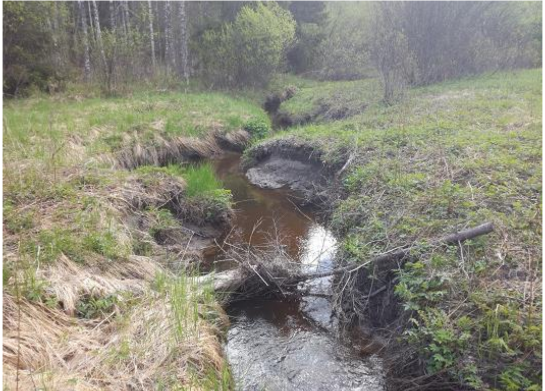
KUVA 8. Maulaanniitun alaosalla on tapahtunut voimakasta syöymistä
