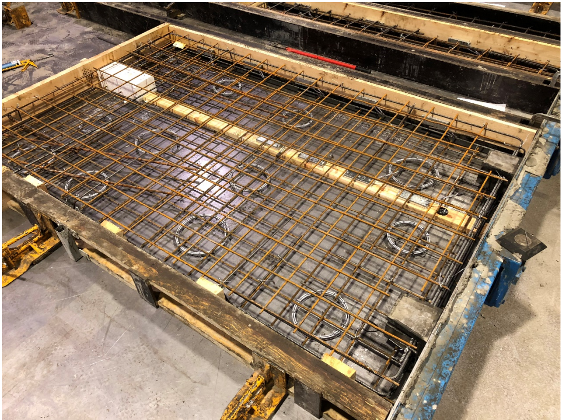
Kuva 31. Valokuva yhdestä pilottikokeilun elementistä, jossa verkot ovat erimuotoisia elementin eri pinnoissa. (Leinonen 2017)
