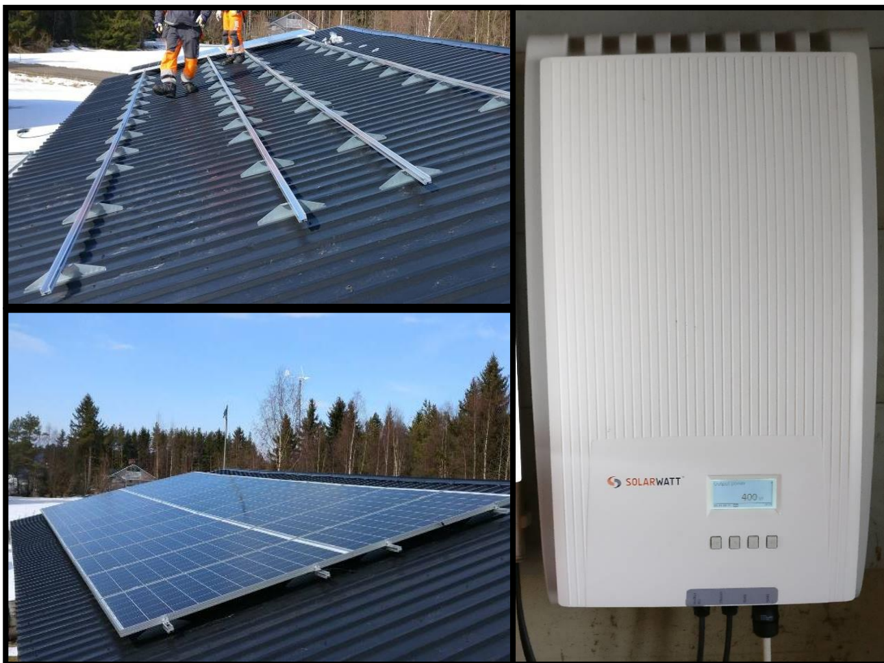
KUVA 2. Kuvia aurinkopaneelijärjestelmän asennuksesta. Vasemmalla ylhäällä paneelien asennuskiskot kiinnitettyinä peltikattoon. Vasemmalla alhaalla paneelit asennettuina katolle. Oikealla invertteri asennettuna seinälle.
