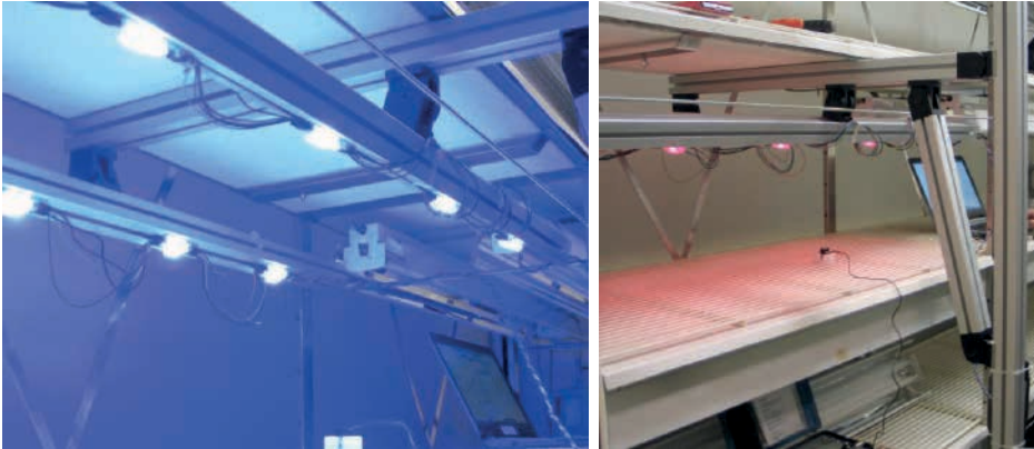
Kuva 4. LED-valaisimien hyllyasennus (kuvat Frida Lappalainen/LUKE).
