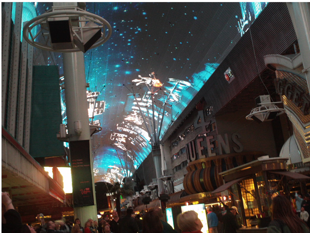
Figur 2. Takinstallation på Fremont Street i Las Vegas, USA – ett extremt exempel på belysningsstyrning.
