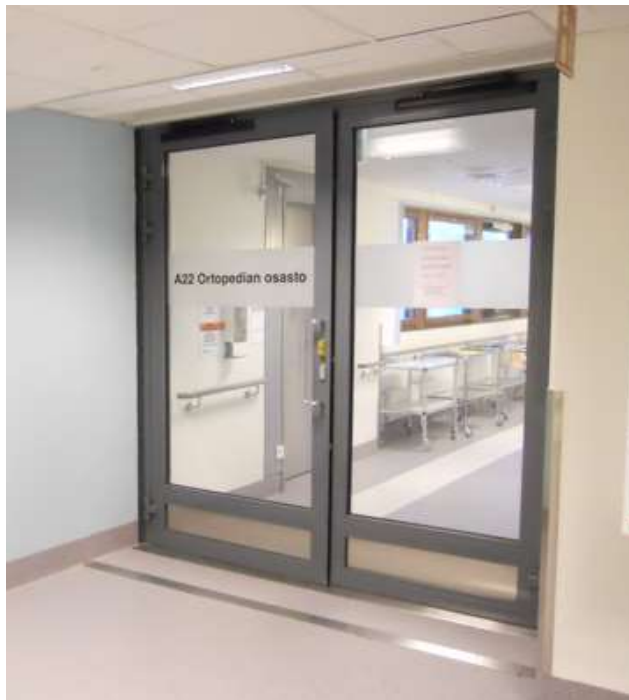
Kuva 32. Automatisoitava ovi Seinäjoen keskussairaalassa (Mäntymaa 2017).
