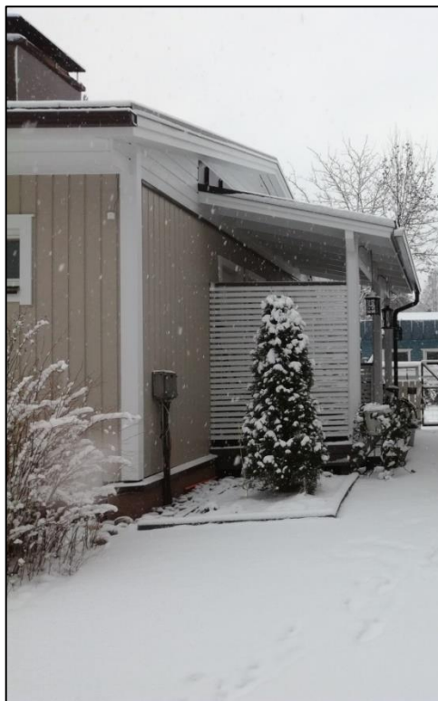
Kuva 5. Asuinrakennuksen pääty (Ojanen 2017)
