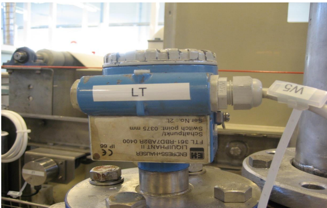
Kuva 13. Pinnankorkeusanturi LT lähemmin kuvattuna.
