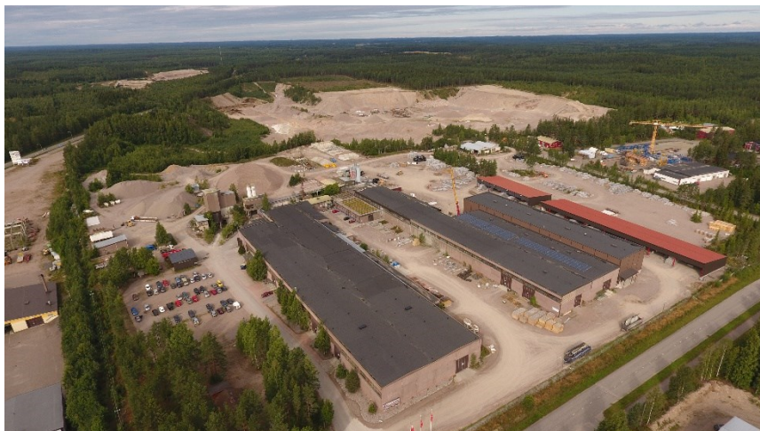
Kuva 12. Ilmakekuvaukset Rakennusbetoni- ja elementti Oy:lle Hollolassa 25.8.2017 (Mäkinen 2017)
