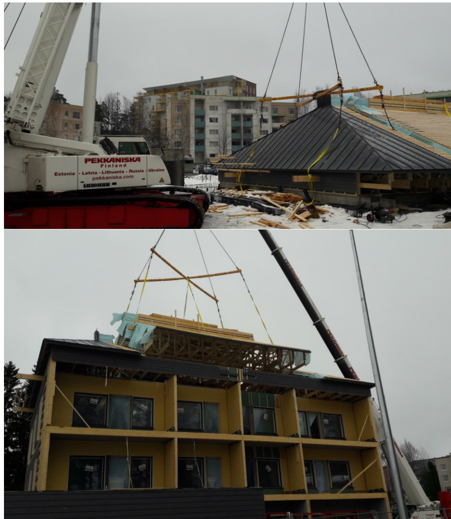
Kuvat 15, 16. Kattoelementtien nostoja
