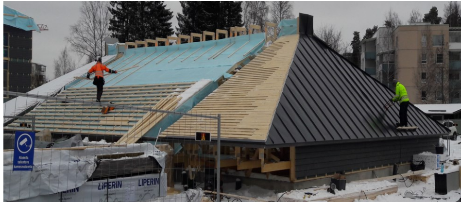
Kuva 14. Auman pellitystä maassa työskennellen
