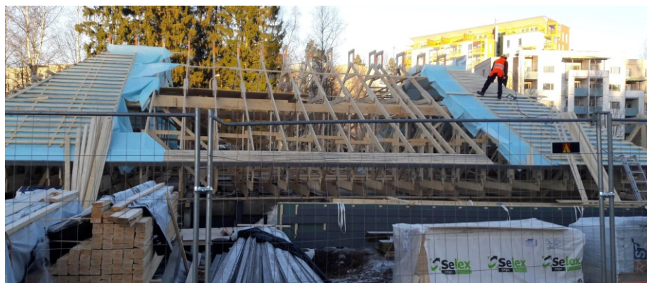
Kuva 13. Vesikaton rakentaminen käynnissä
