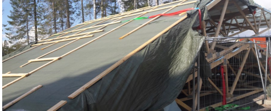
Kuva 17. Säsuojakattojen välivarastointia työmaalla.
