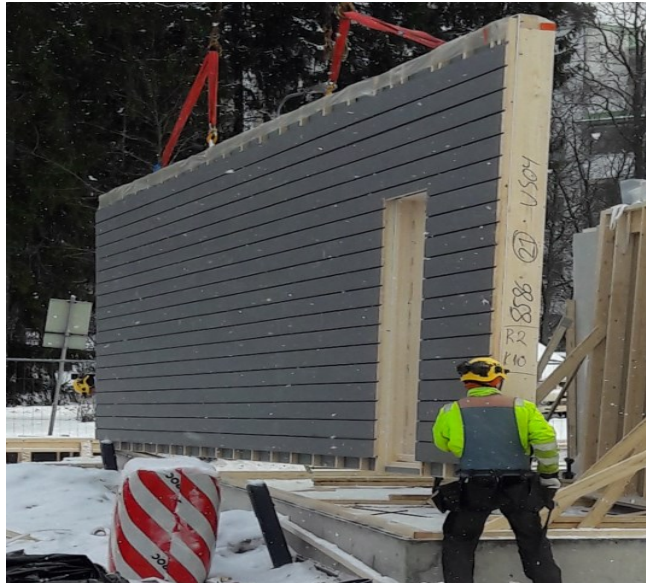
Kuva 12. Ulkoseinäelementin asennustyöt käynnissä
