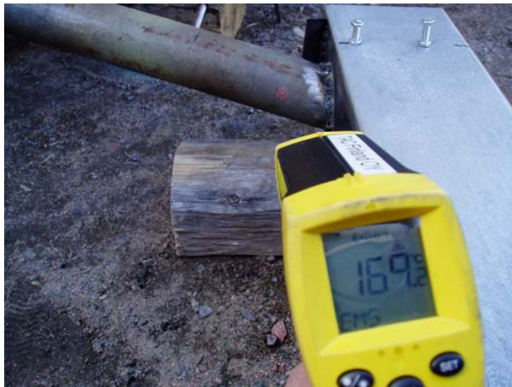
Kuva 22 Nestekaasupoltin toimi hyvänä lisälämmön antajana.
