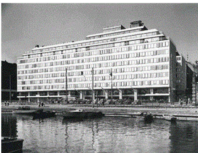
Kuva 1. Hotelli Palace. (Elementtisuunnittelu.fi)
