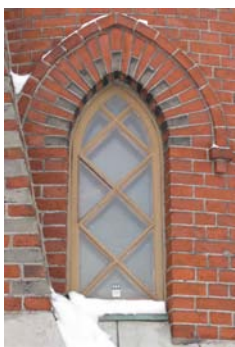
Kuva 26. Kotkan kirkon ikkuna.
