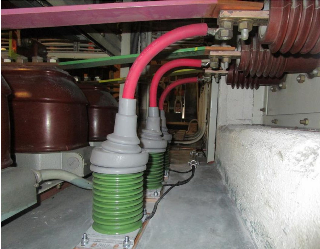
KUVA 27. Generaattorin virtakiskoihin asennetut 80 pF EMC-anturit (28)
