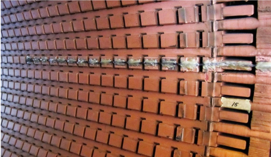
KUVA 30. Levypaketin pinnalle asennettu TF-anturi (15)
