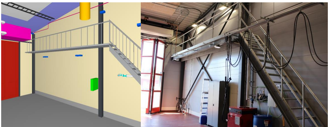
Kuva 17. Valokuva autonpesuhallin seinärakenteista
