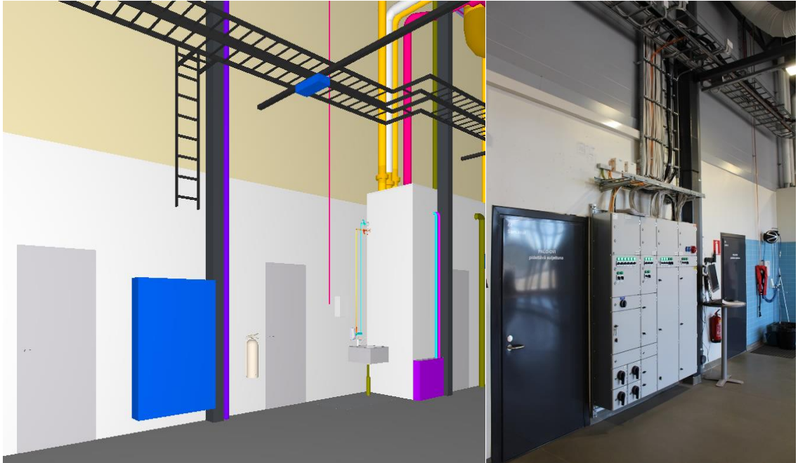
Kuva 11. Sähköasennuksille on jonkinlaiset tilavaraukset mallissa.
