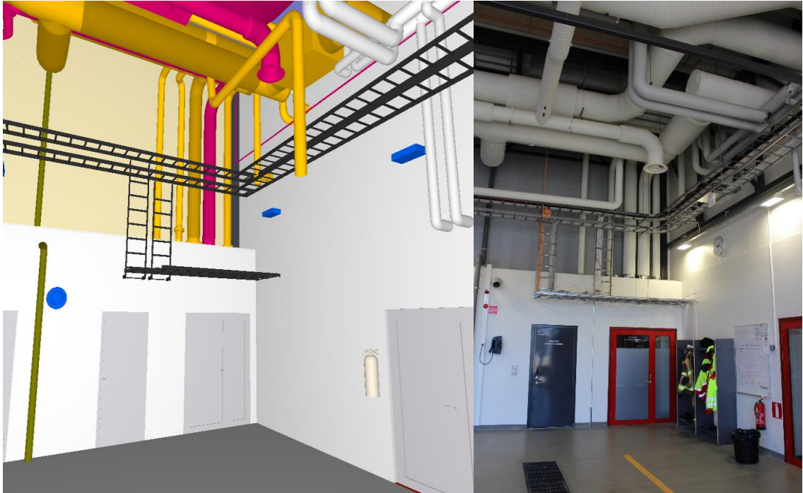
Kuva 13. Ilmanvaihtokanavien todellinen kulku
