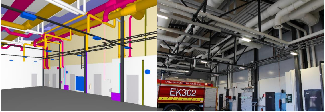
Kuva 14. Mallinäkömä ja valokuva autohallin rakenteista ja asennuksista
