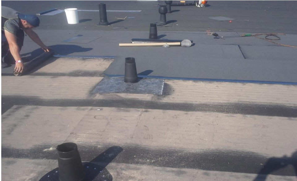
Kuva 12. Pintakermin asennus
