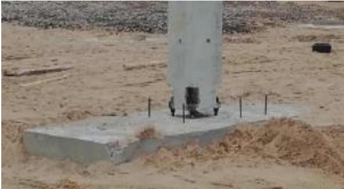
Kuva 6. Pilarin ja anturan liitos
