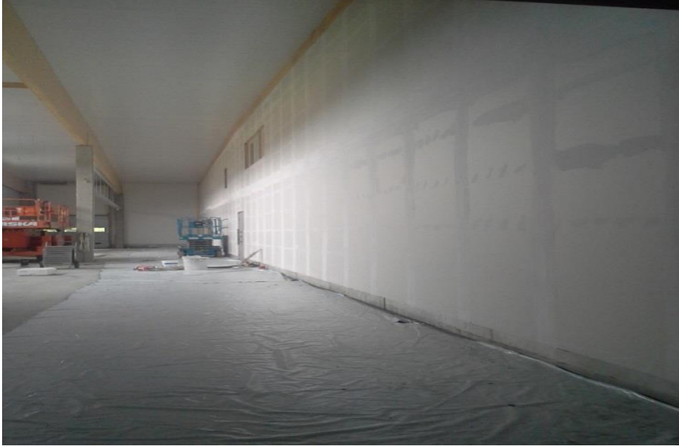
Kuva 14. Laajennuksen välisen seinän pinnoitus
