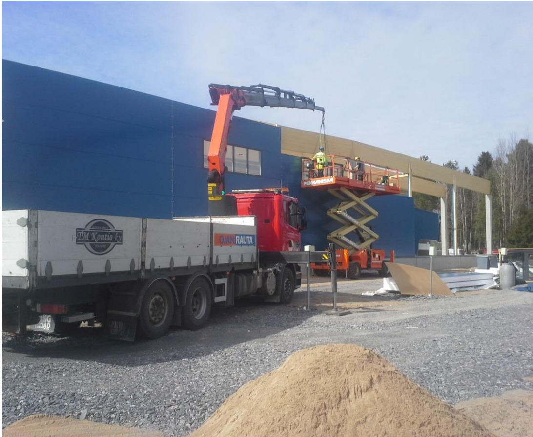
Kuva 7. Seinäelementin asennusta
