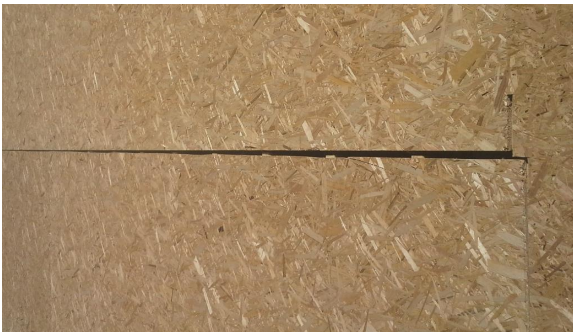
Kuva 10. Elementtisaumojen rakoja
