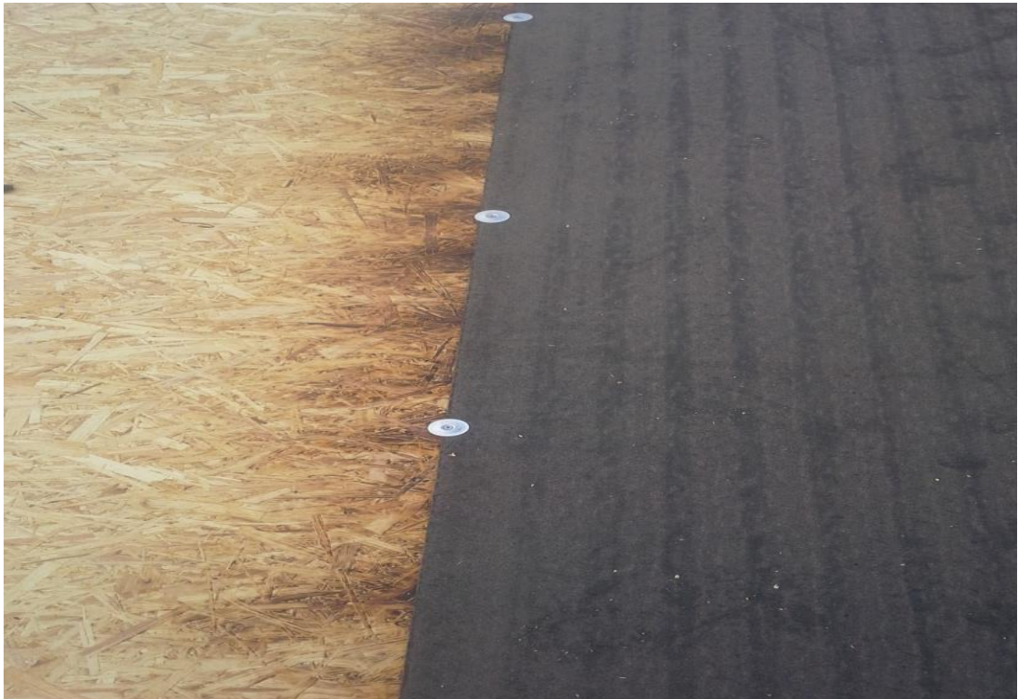
Kuva 11. Aluskermi mekaaninen kiinnitys
