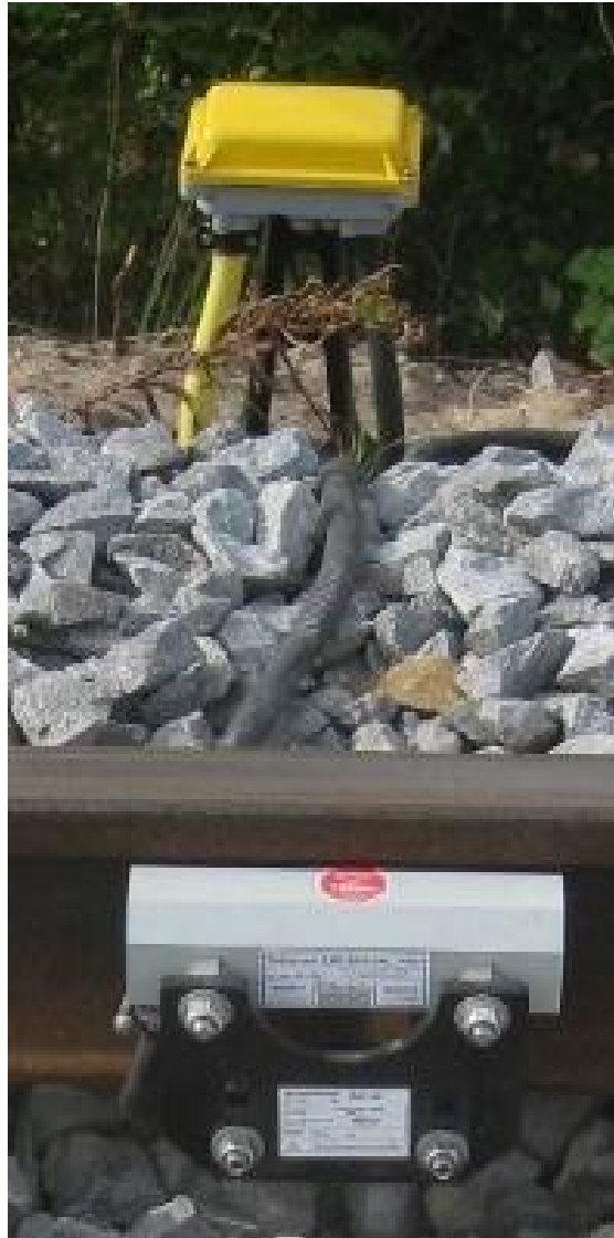
Kuva 1. Akselinlaskija-anturi ja kytkentäkotelo
