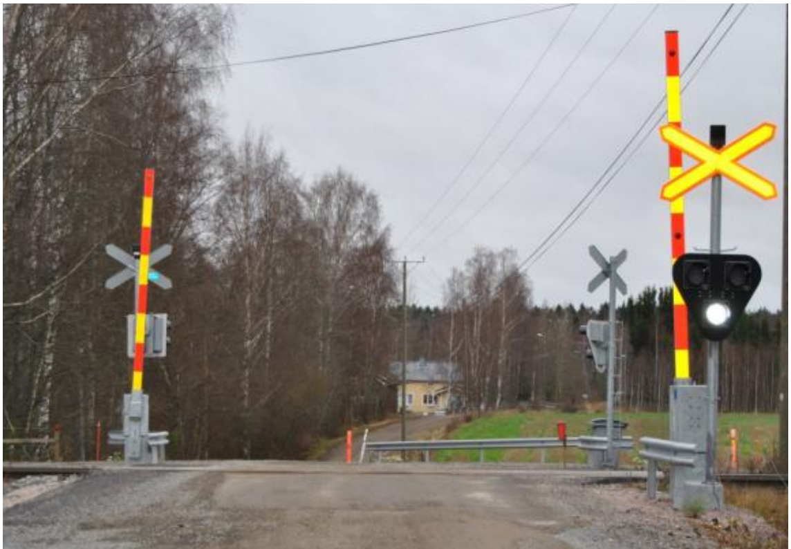
Kuva 4. Puolipuumilaitos. (Liikennevirasto 2012c, 1)
