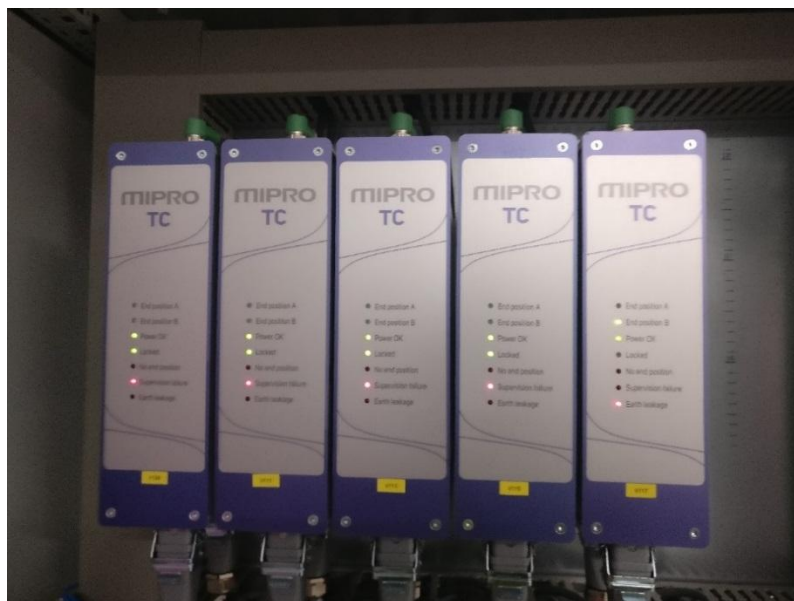
Kuva 8. Vaihteen elektroninen ohjausryhmä
