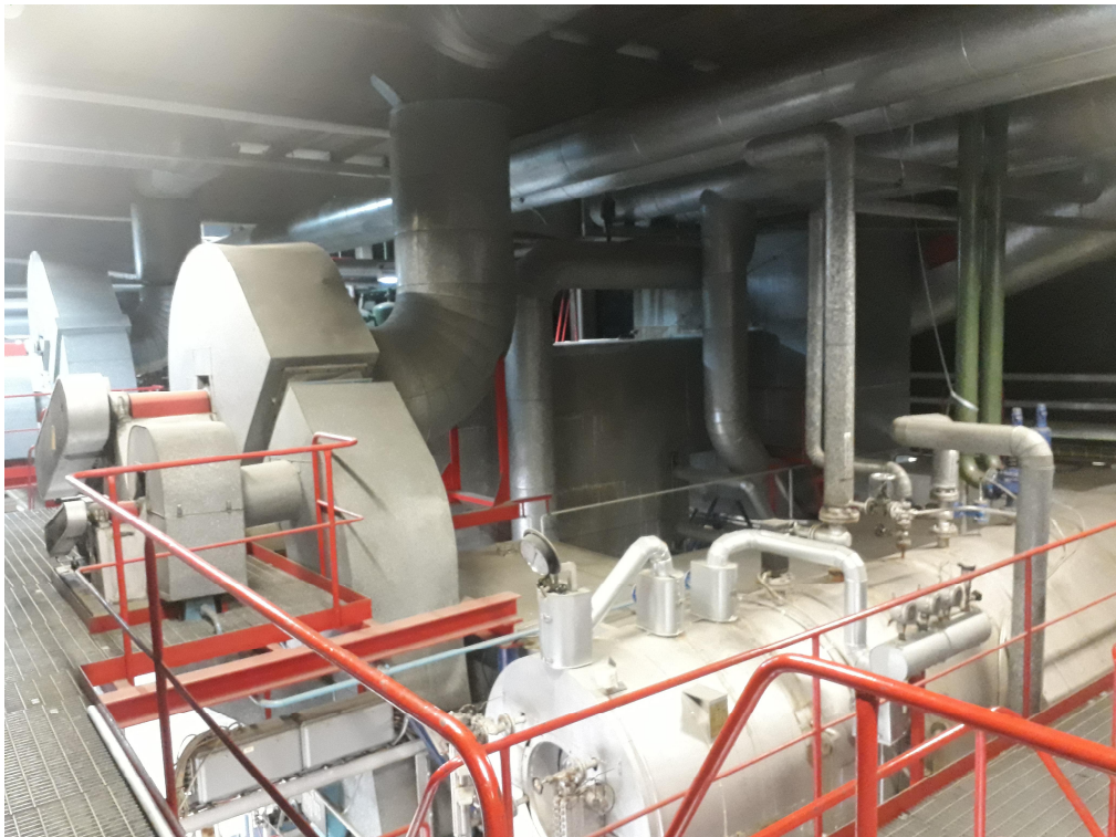
Kuva 5. A-puolen kattilahallin ylätaso.
