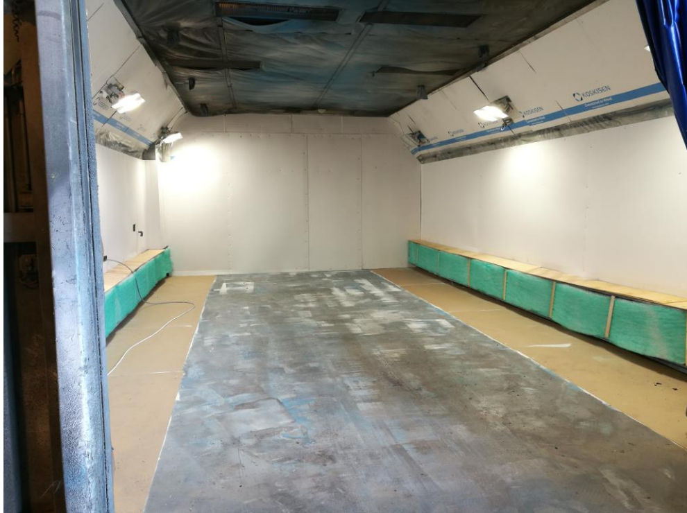
KUVA 6. Maalaamo kaksi eli "pikku maalaamo".
