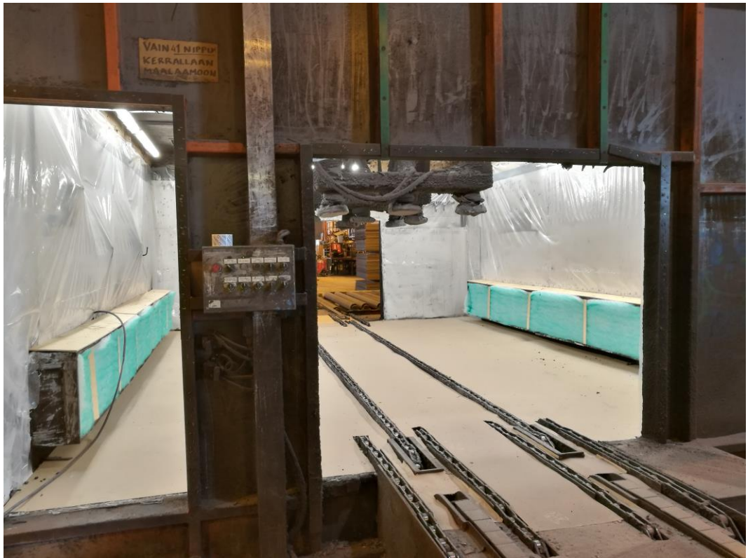
KUVA 5. Linjamaalaamo huoltoseisakin jälkeen (maalaamo yksi).
