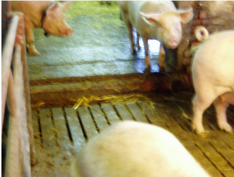
KUVA 8 Makuualueen ja sontimis- ja ruokailualueen välillä olevassa kulkuaukossa on vajaan 20 cm:n askelma. (Niina Aalto 2010.)
