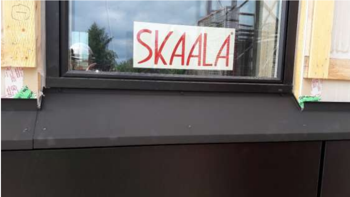
KUVA 5. Asennettuja tippapeltejä
