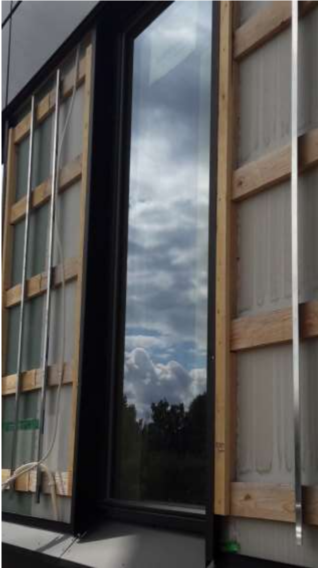
KUVA 6. Ikkunapielen pellit asennettu
