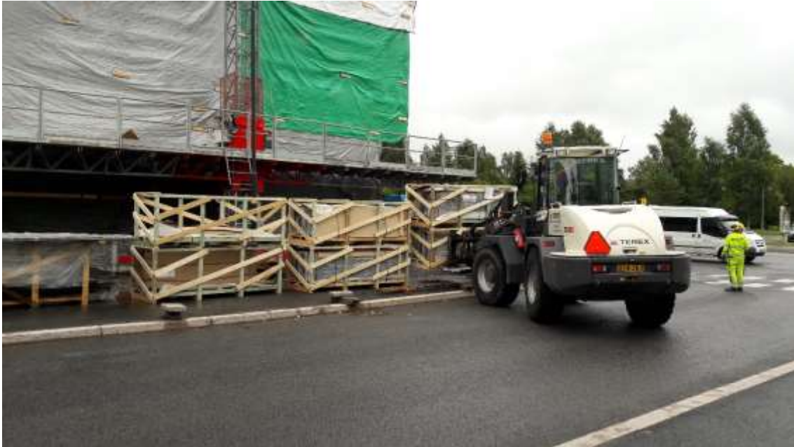
KUVA 1. Materiaalin purkutyö käynnissä
