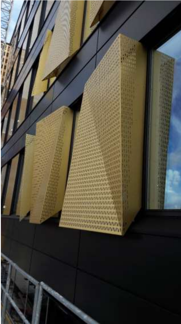
KUVA 10. Valmiita 3D-elementtejä
