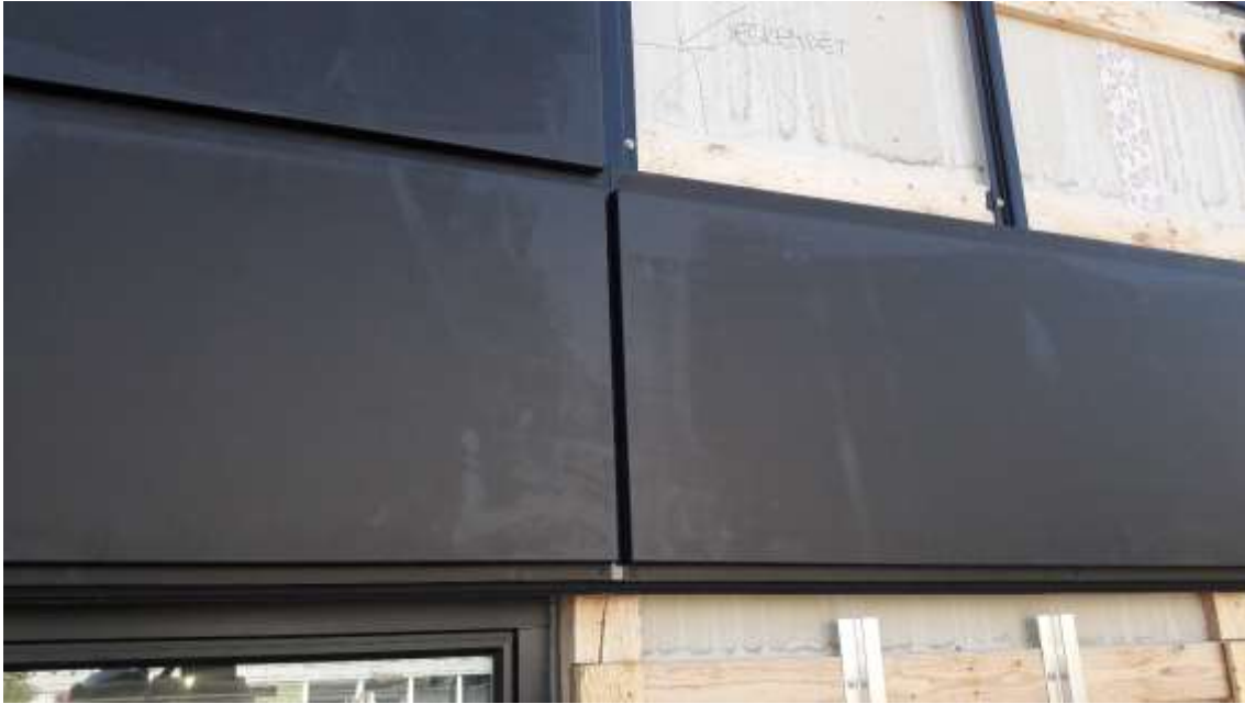
KUVA 4. Asennettuja kasettipeltejä
