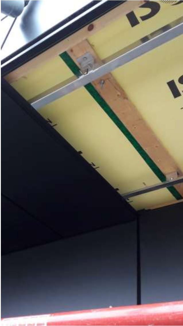
KUVA 12. Lipanpohjan pellitystä
