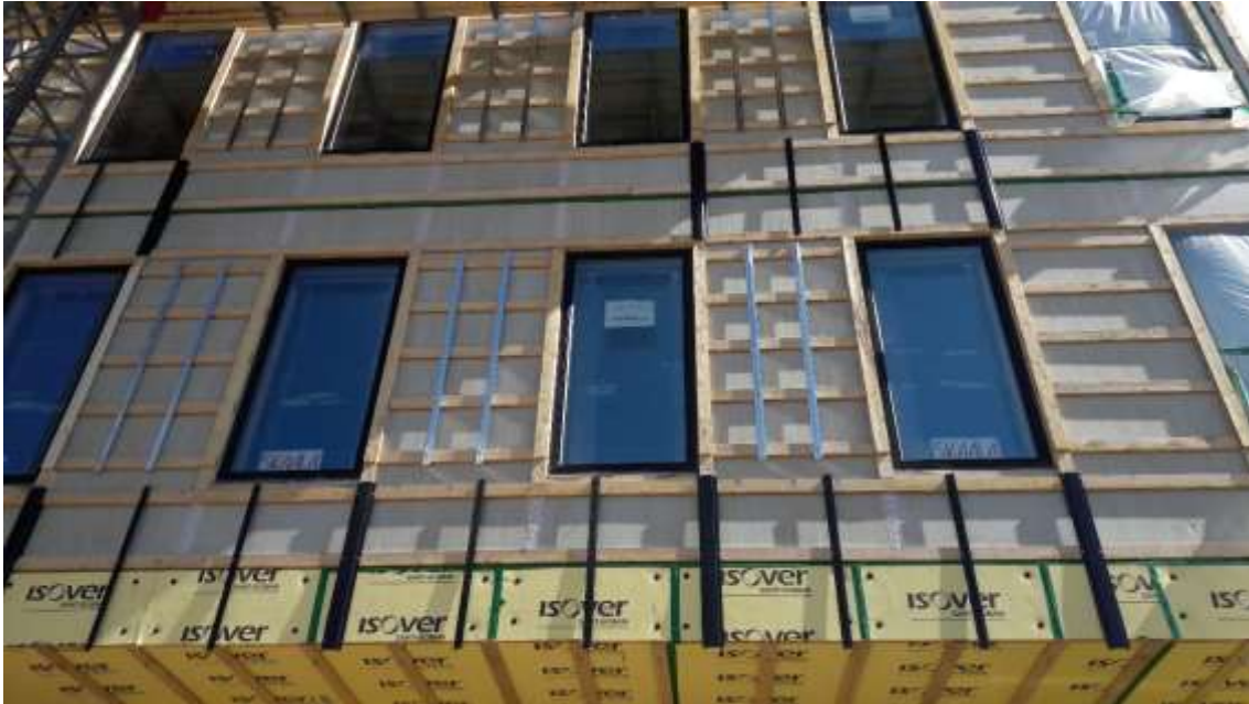
KUVA 3. Valmiiksi koolattua ulkoseinää
