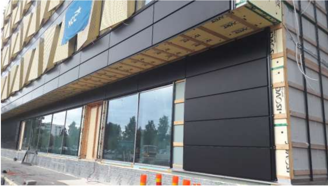
KUVA 11. Nurkkakasettien asentamista
