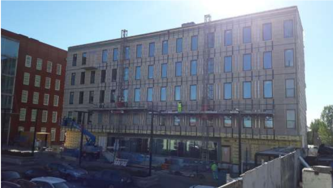
KUVA 2. Työskentelyä mastolavoilla ja kuukulkijalla
