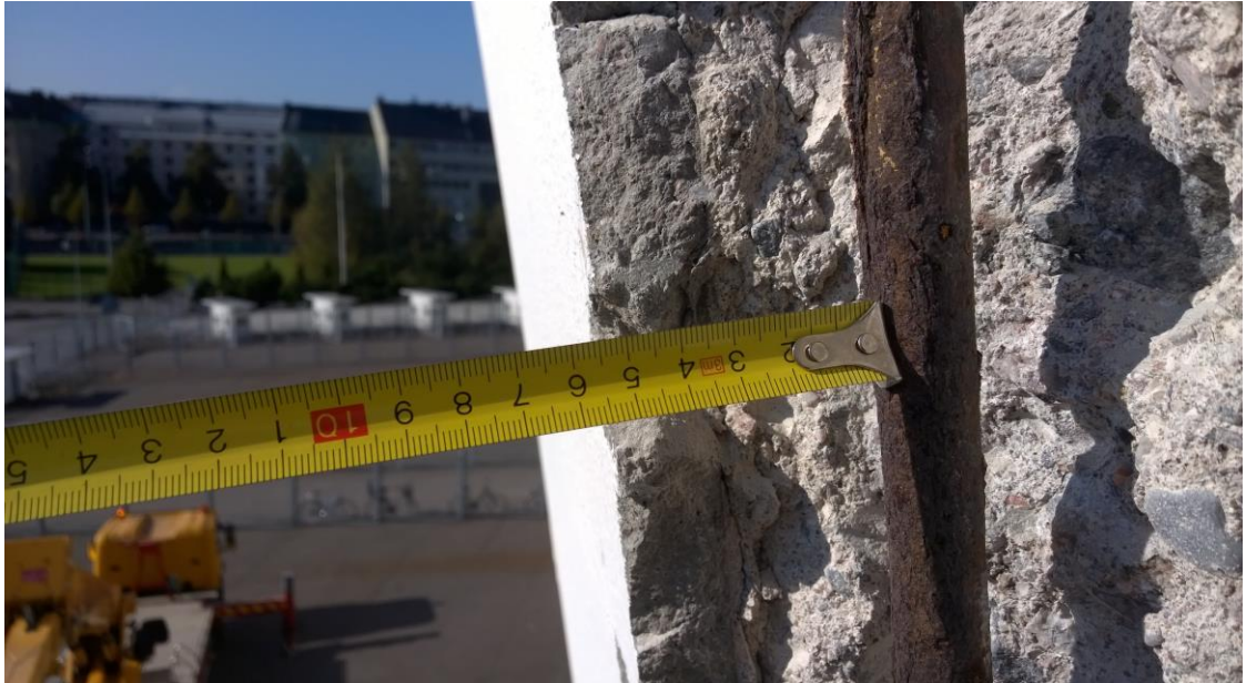
Kuva 12. Rakenneavaus uloimpaan kehäpilariin linjalla 17, kuvattu 30.09.2014
