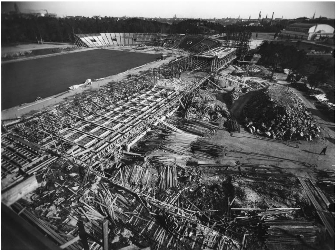
Kuva 2. Valokuvaaja Foto Roos 10.08.1936, Helsingin kaupunginmuseo. Pääkatsomon rakentaminen käynnissä
