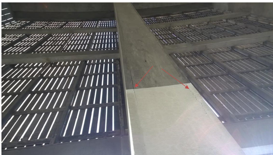
Kuva 10. Pystysuuntaisia pitkiä halkeamia pilarissa, kuvattu 30.09.2014
