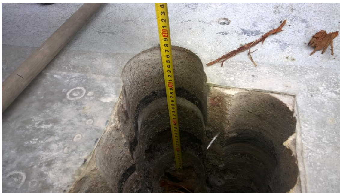
Kuva 14. Rakenneavaus urheilumuseon terassiin, kuvattu 02.10.2014
