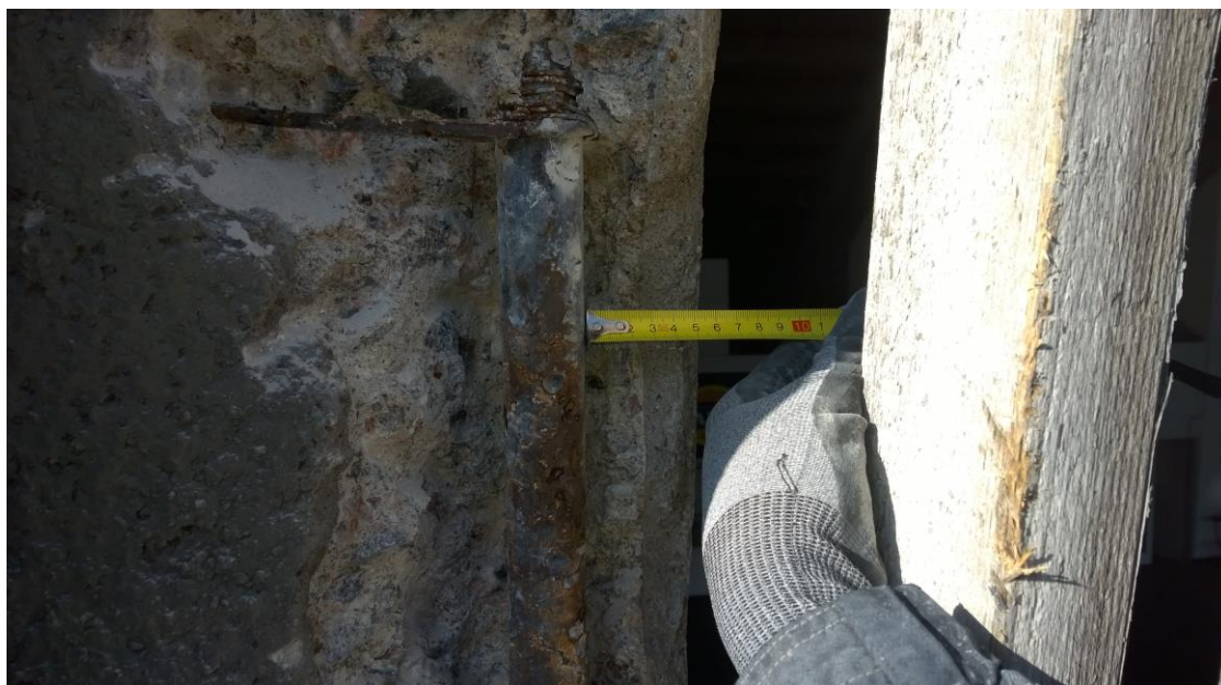
Kuva 11. Rakenneavaus uloimpaan kehäpilariin linjalla 32, kuvattu 30.09.2014
