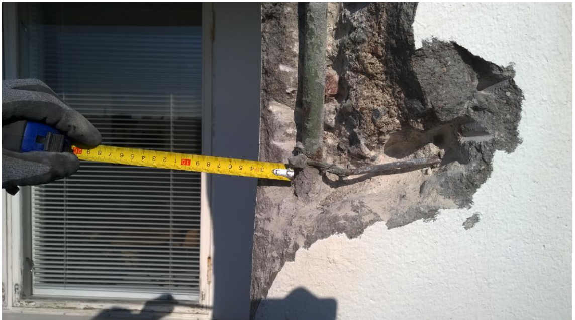
Kuva 13. Rakenneavaus uloimmasta kehäpilarista linjalla 13, kuvattu 30.09.2014
