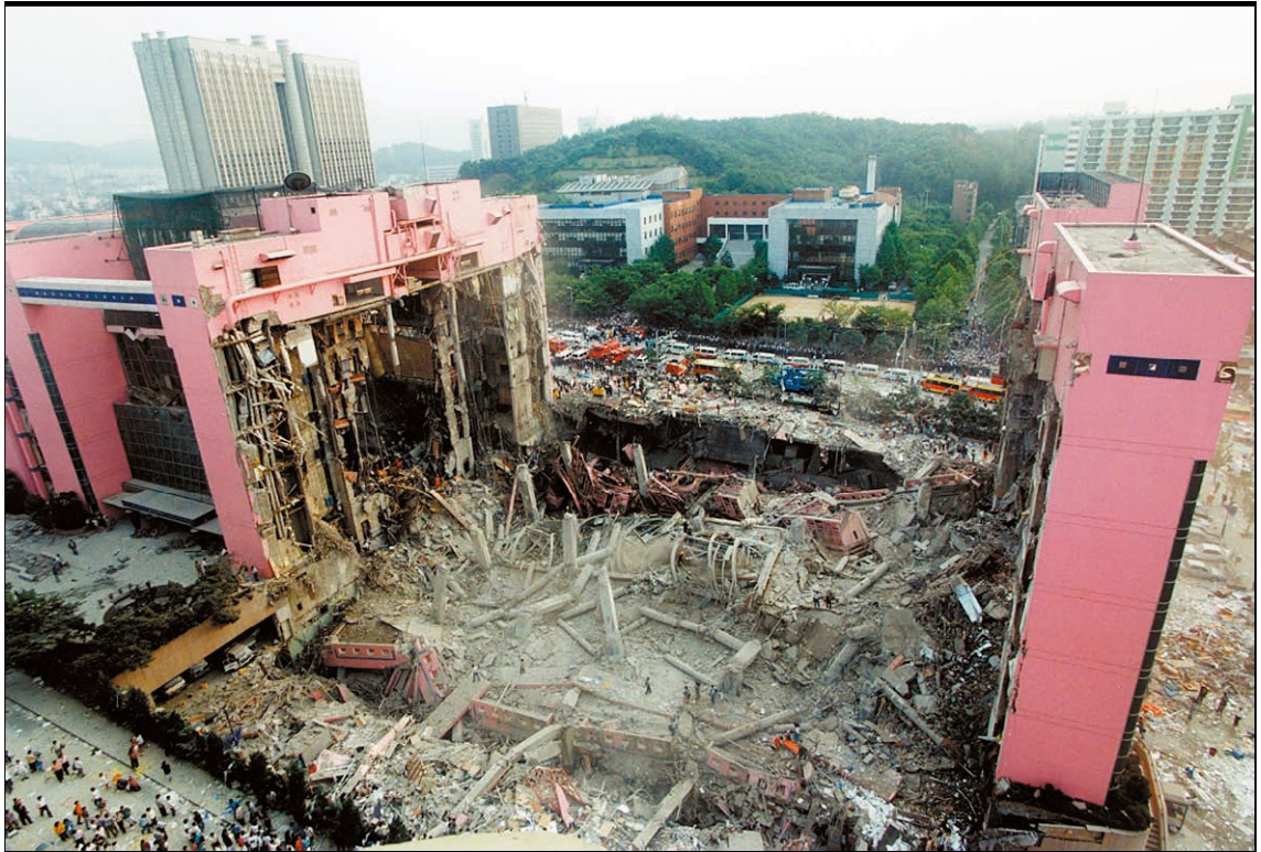
Kuva 4. Seoullissa sijaitsevan Sampoongin tavaratalon romahdus vuonna 1995 rakenteellisen vian seurauksena. [31.]
