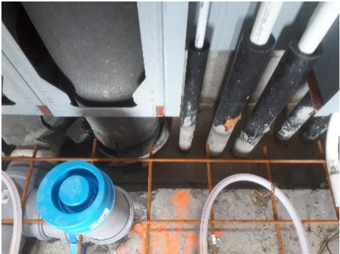
Kuva 12. Cefo-elementtien välipohjan palokatko valu
