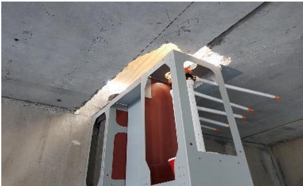
Kuva 3. Cefo-elementin varaus ontelovälipohjassa, tässä elementissä on kolme runkokasettia
