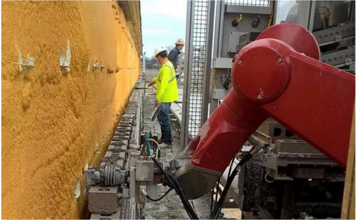
Kuva 5. Sam-robotti muuraa työmaalla [15].
