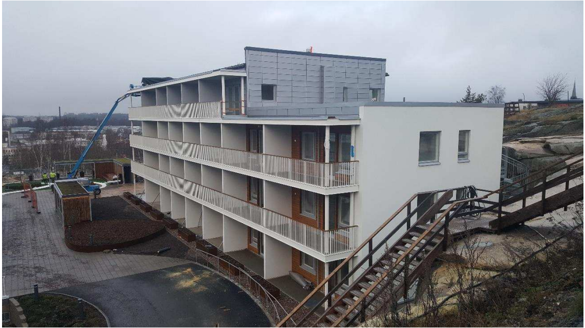
Kuva 5. Asunto-osakeyhtiö Turun Korkeavuori rakentamisvaiheessa 2.1.2018.
