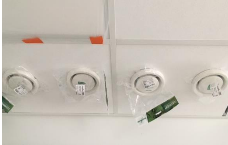
Kuva 3. Asennetut päätelaitteet suojattuna. (NCC Suomi Oy.)
