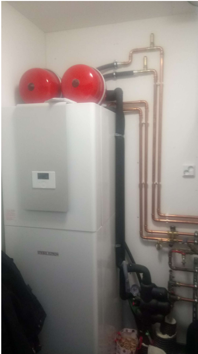
Kuva 5. Kiinteistön maalämpöpumppu.
