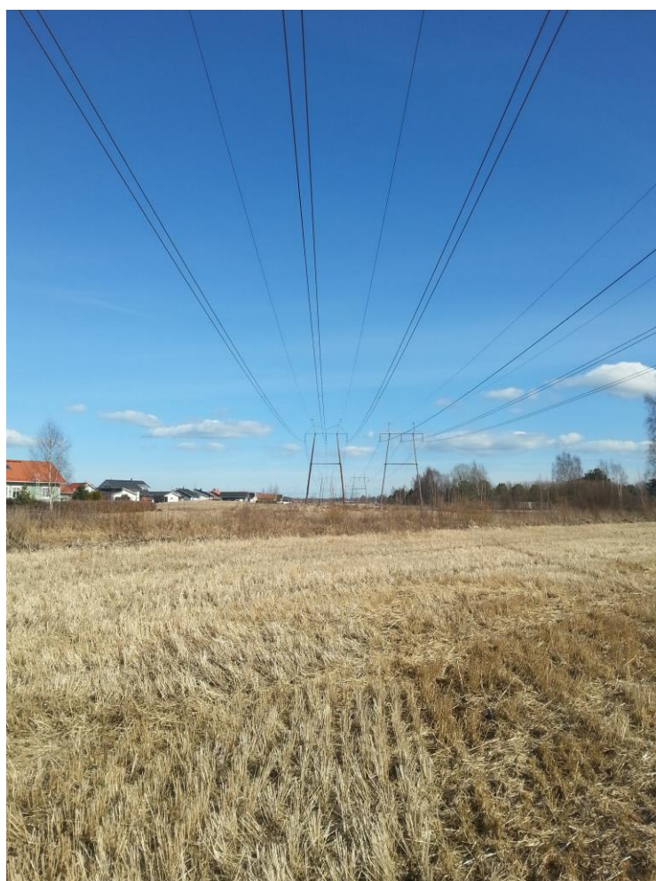
KUVA 11. Mittauspaikka voimajohdon alla.
