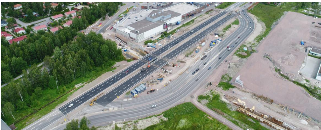
Kuva 9. Hannuksenpellon työmaa 4.7.2017 yhtä päivää ennen uuden Länsiväylän patkän avaamista.
