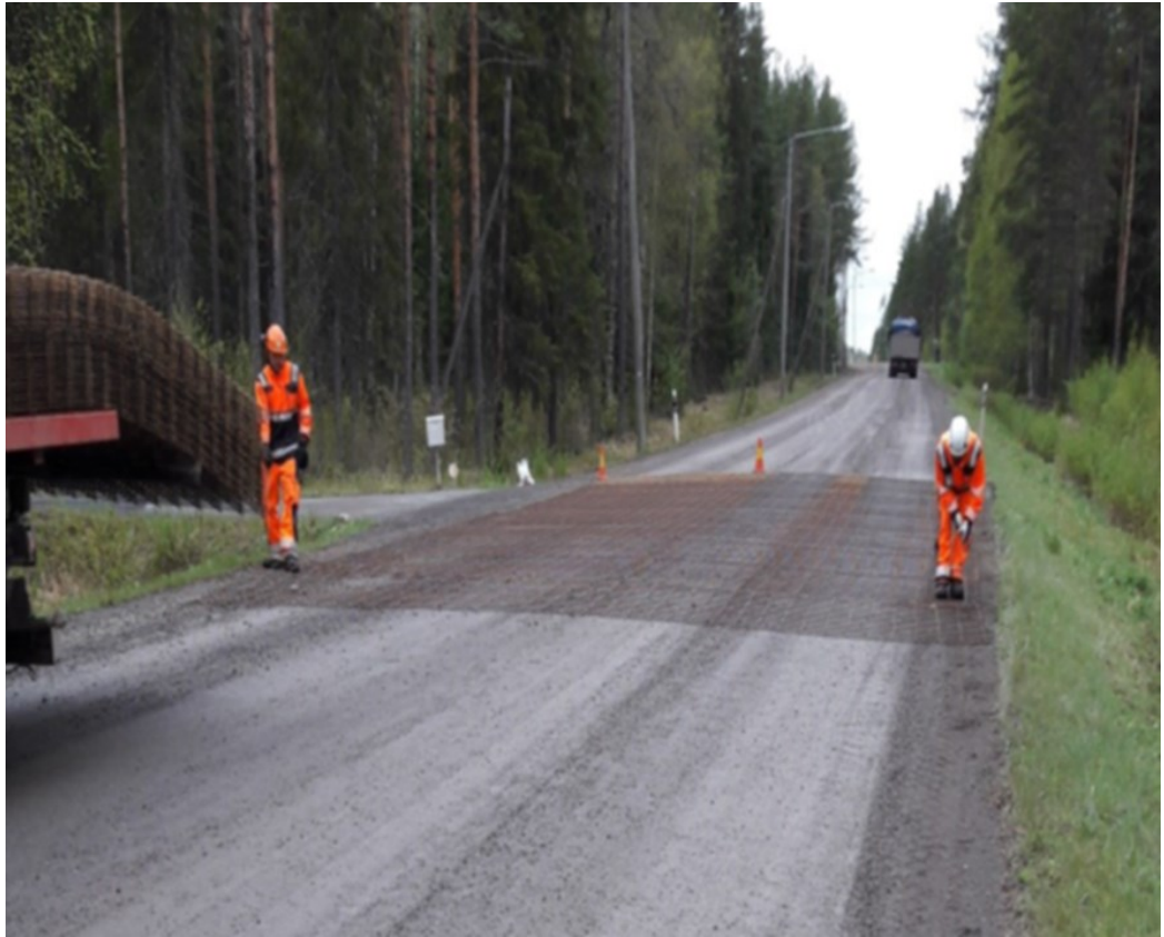
Kuva 4. Teräsverkkojen asennus (Kumpulainen 2017).
