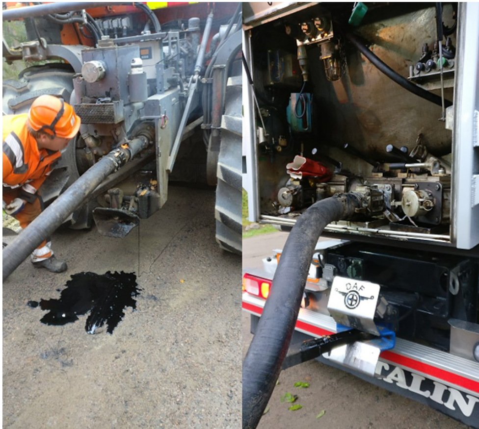
Kuva 8. Bitumiputken liitokset, vasemmalla stabilointikone ja oikealla bitumiauto (Lindell 2017).
