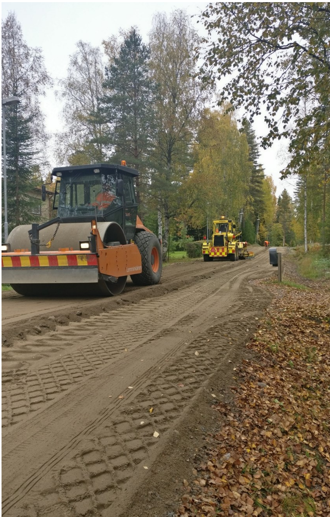
Kuva 10. Stabiloidun pinnan muotoilu ja tiivistys (Lindell 2017).
