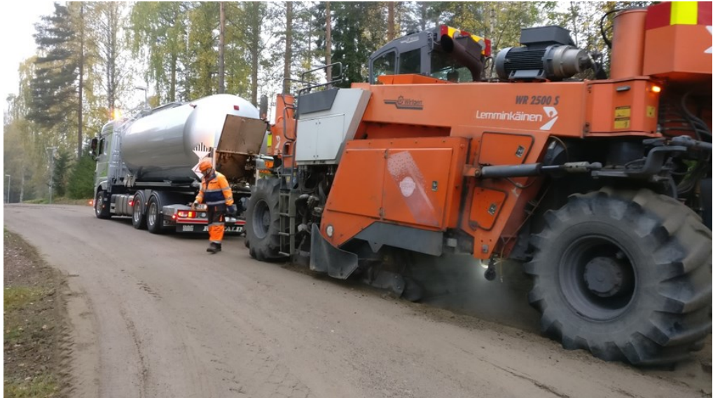
Kuva 9. Stabilointikone ja bitumiauto liikkeessä (Lindell 2017).
