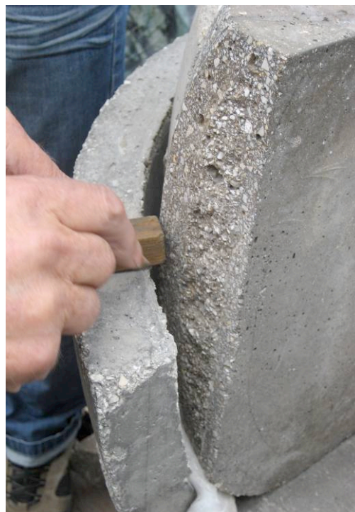
Kuva 16. Laajennusvara takkaluukun leventämiseen rakenteesta
