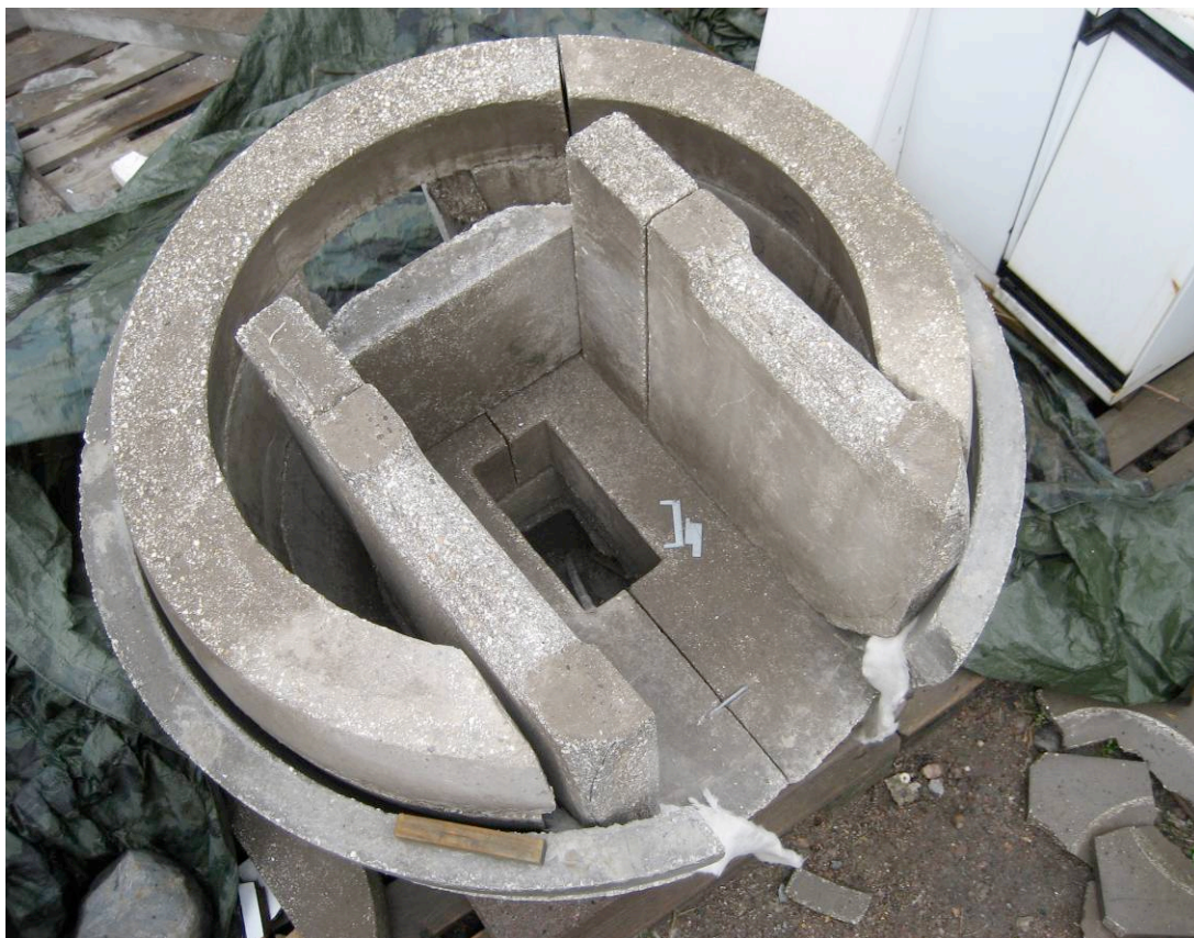
Kuva 14. Pallotakan rakenne sisältä
