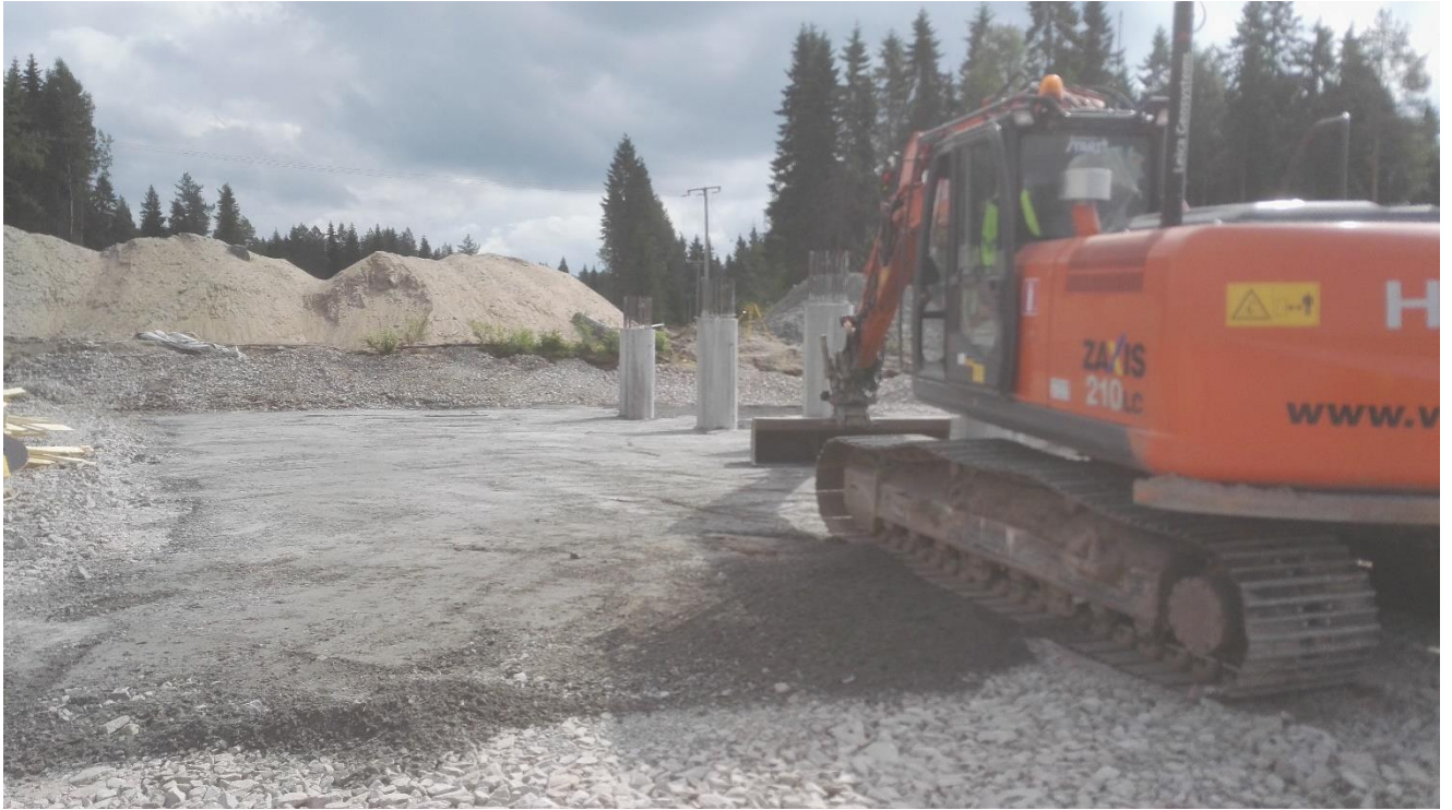
KUVA 11. 0-32 mm:n murskeen levitystä sekä taustalla on murskeverhoiltu luiska ja moottoritien rakennekerrosten hiekkaa
