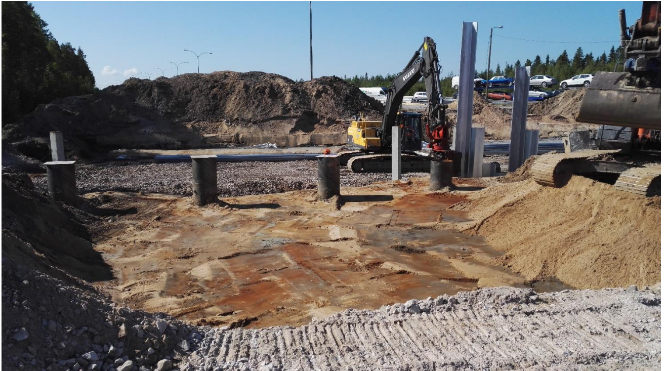
KUVA 7. Rakennekerrosten talteenottoa
