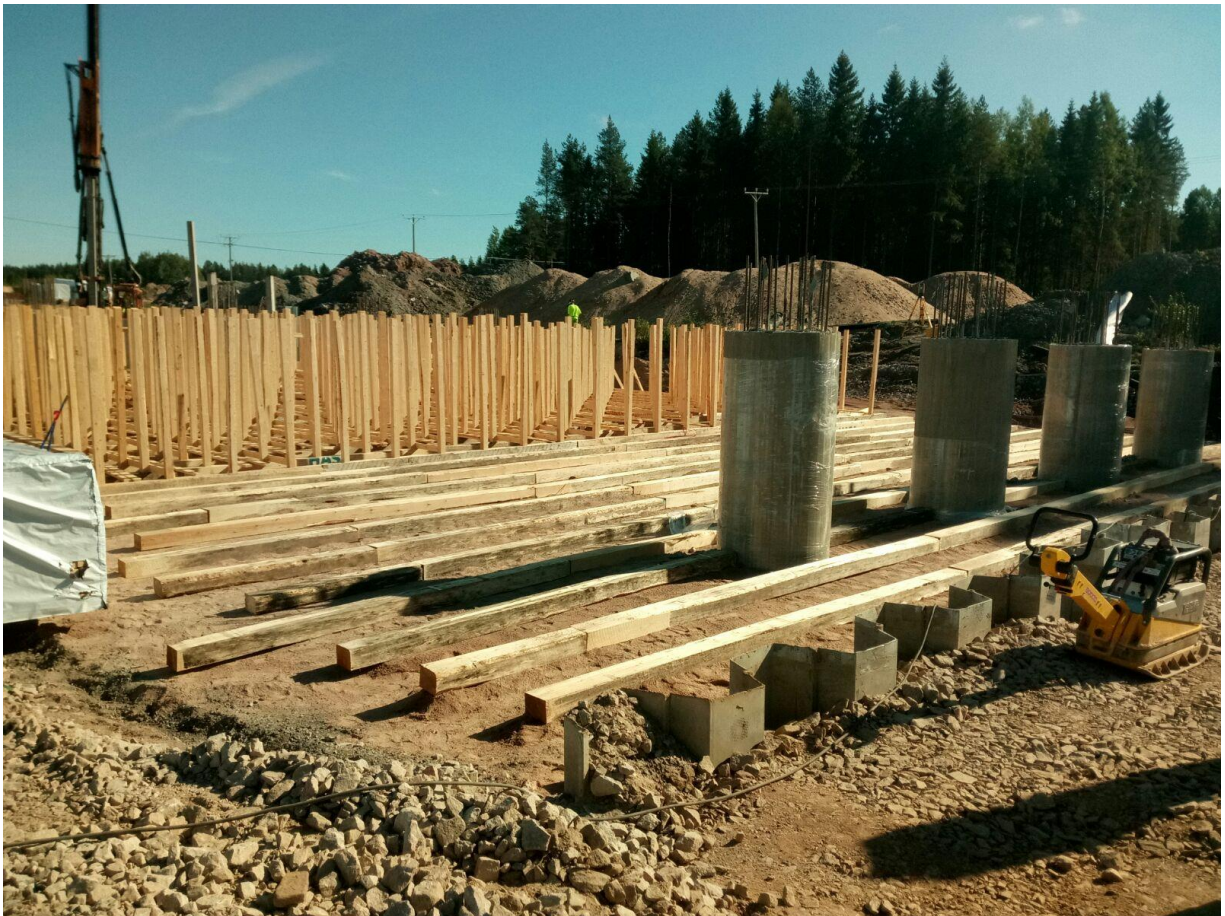
KUVA 13. Tukitelineiden rakentamista
