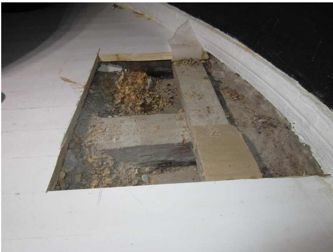
Kuva 19. Maanvastaisen alapohjarakenteen rakenneavaus.
