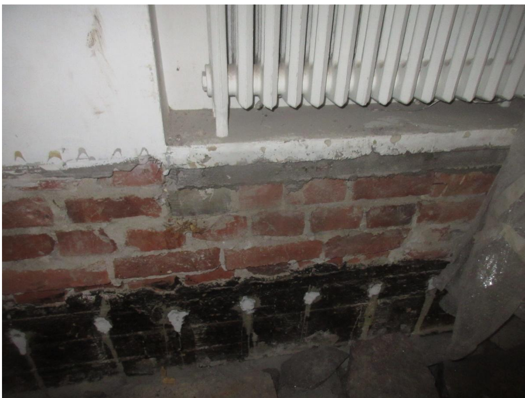
Kuva 14. Ulkoseinään toteutetut kapillaarikatkot injektoimalla.
