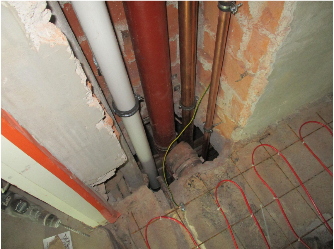
Kuva 10. Uudet viemäriputket ja vesijohdot nousuhormissa.
