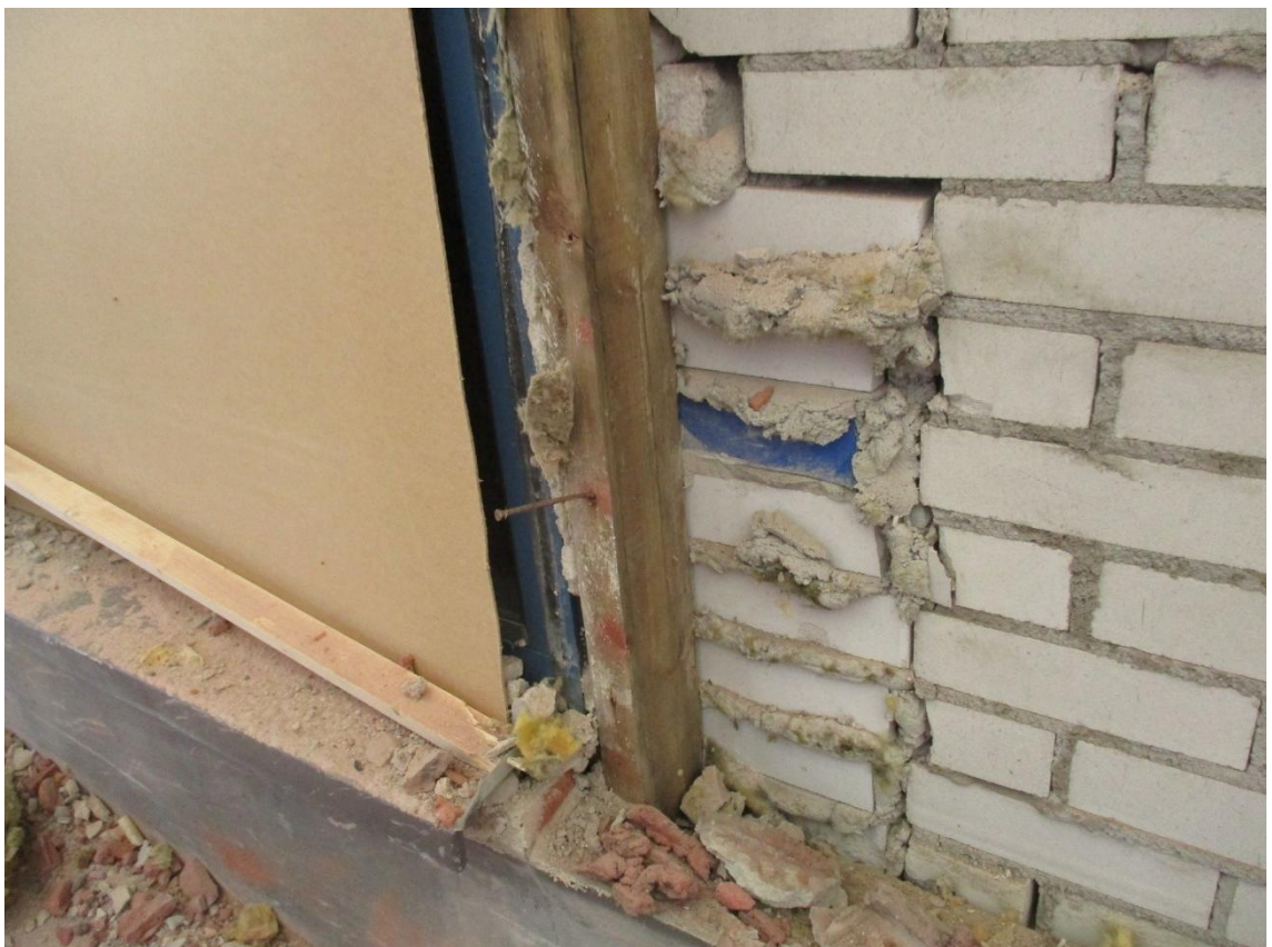
Kuva 26. Epätasainen sisäkuoren ulkopinta julkisivun purkutöiden jälkeen.
