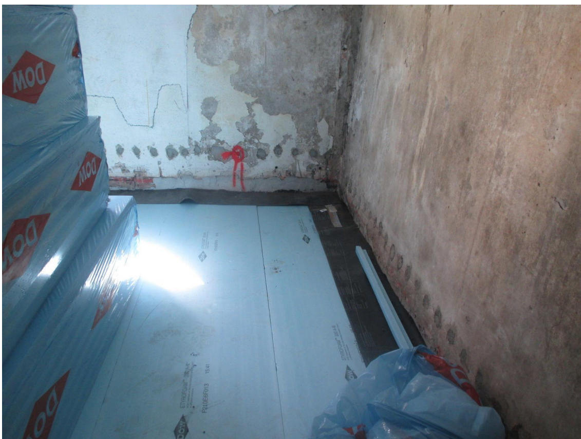
Kuva 20. Maanvaraisen laatan lämmöneristeet ja radonkaistat asennettu sekä kantavien seinien kapillaarikatkot tehty injektoimalla.
