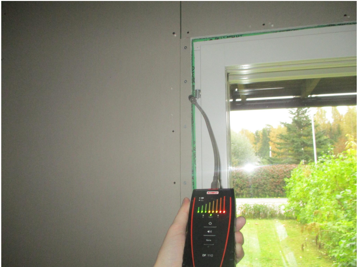
Kuva 6. Ikkunatiivistyksen laadunvarmistus merkkiainekokein.
