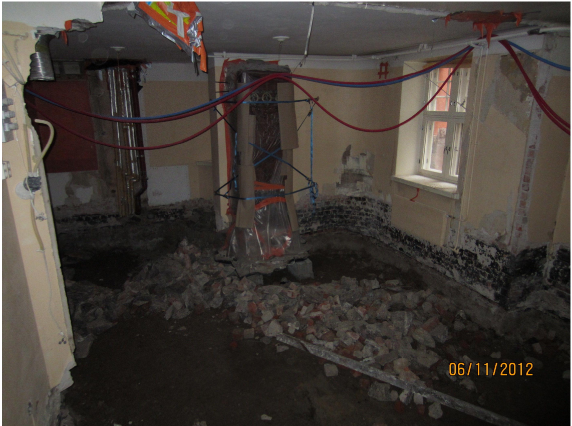
Kuva 24. Väliseinät ja alapohjarakenteet purettu.
