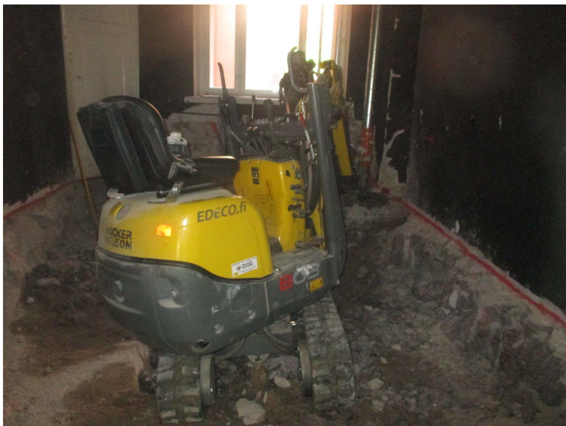
Kuva 21. Louhintaa sisätiloissa louhintarobotilla.
