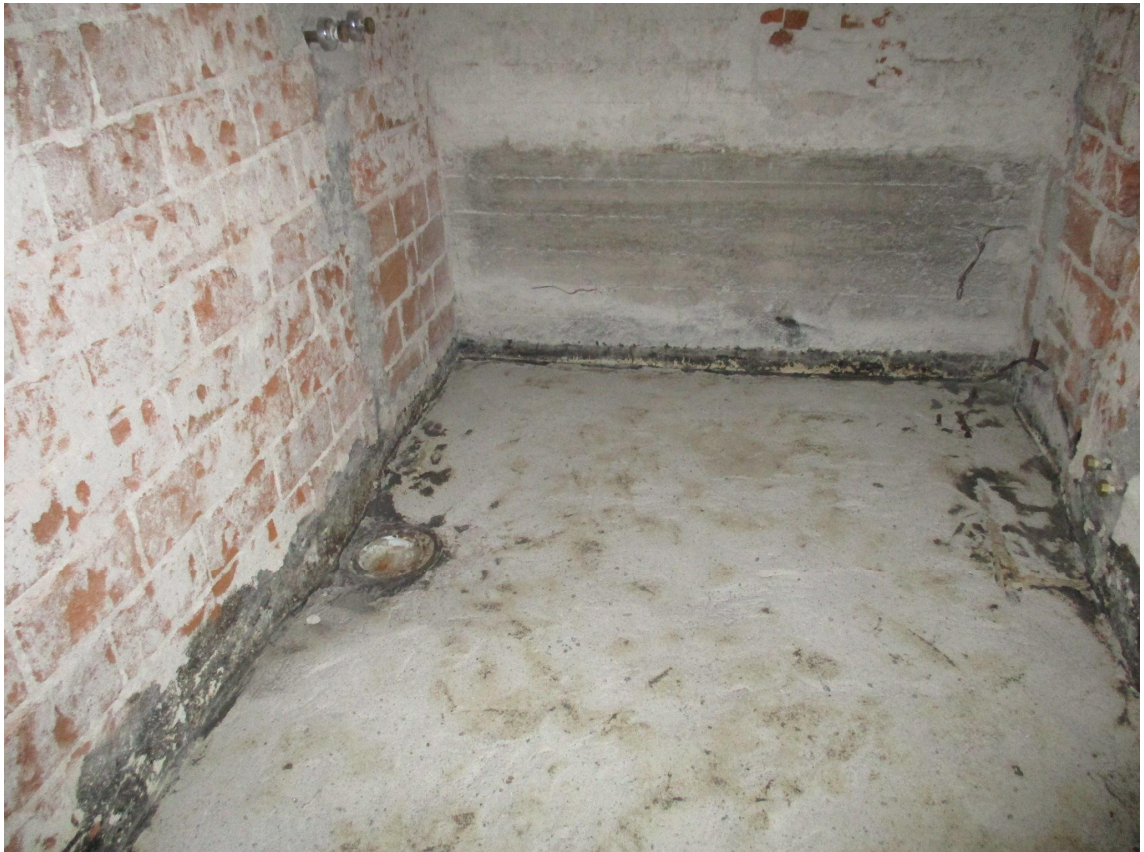
Kuva 4. Märkätilan rakenteet purettu runkorakenteeseen saakka.
