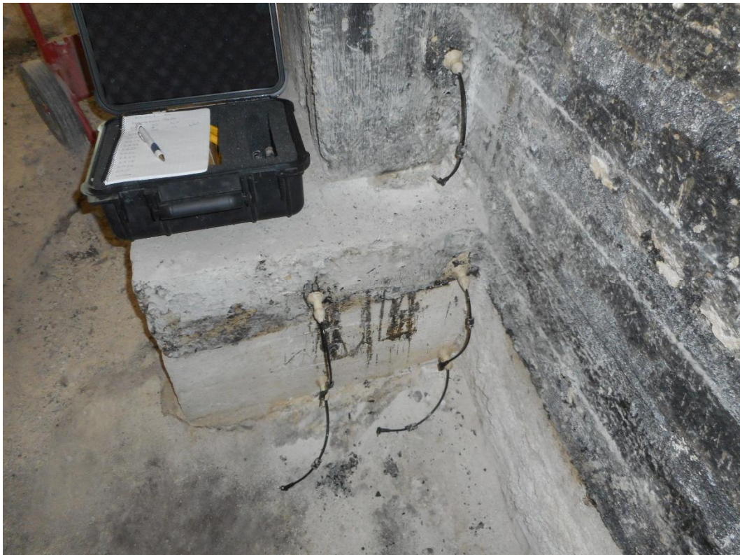
Kuva 12. Kantavien rakenteiden kosteusmittaukset porareikämittauksin.
