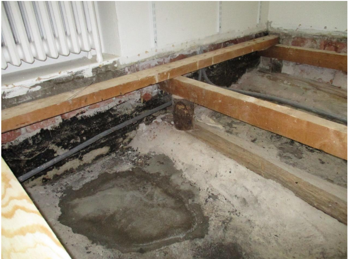
Kuva 11. Vettä lammikoitunut maanvastaisen betonilaatan päälle.
