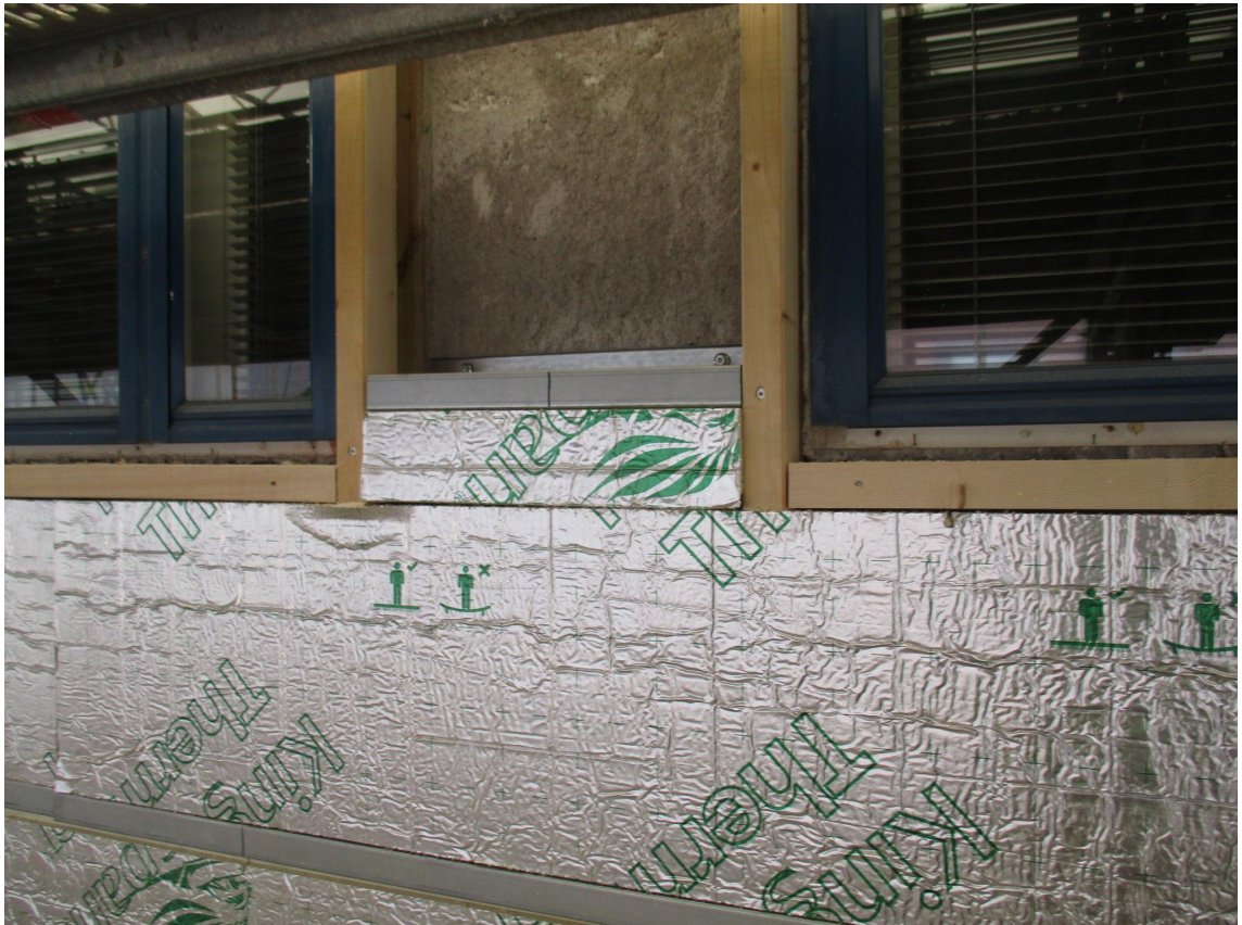
Kuva 27. Julkisivun lämmöneristystyöt käynnissä tasoitustöiden jälkeen.
