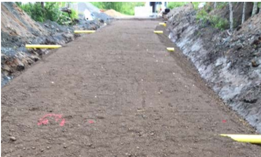
Kuvio 7. Älyputkien asennus testialueelle, Fill-R-rakennekerrokseen
