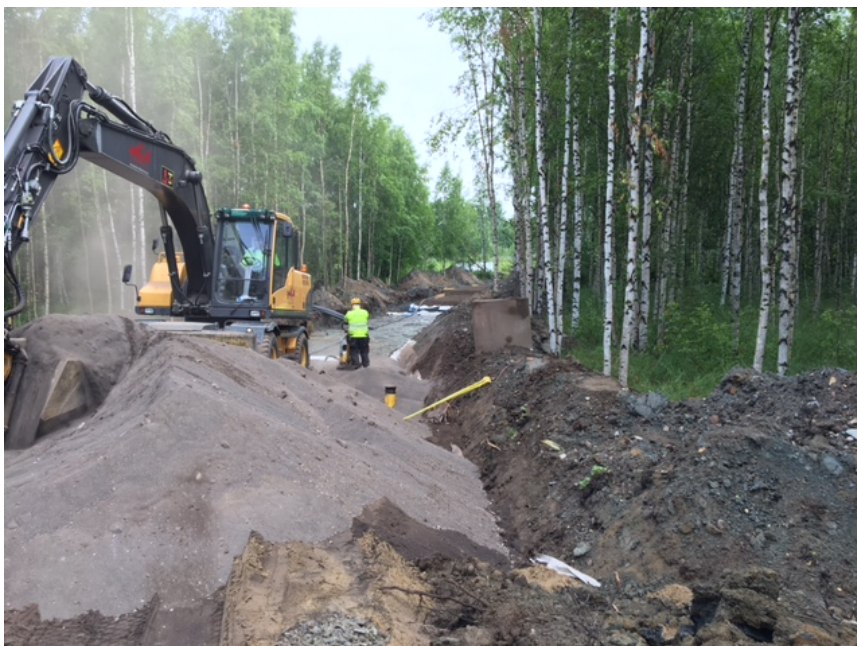
Kuvio 13. Pohjatuhkan levitys rakenteeseen
