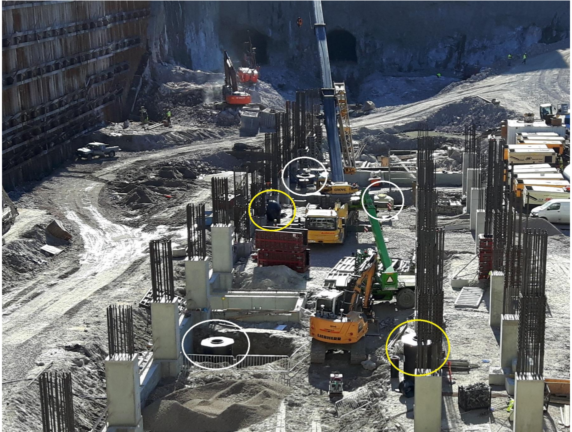
Kuva 8. Asennettuja pumppaamoja (valkoinen) ja asennusta odottavia (keltainen) 03.08.2016
