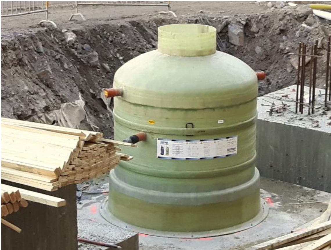
Kuva 6. Jätevesipumppaamo metrovarauksella
