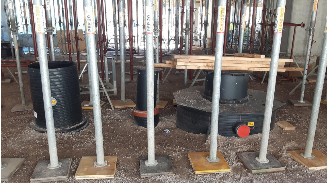
Kuva 9. Holvitukien viidakko asennetun pumppaamon ympärillä
