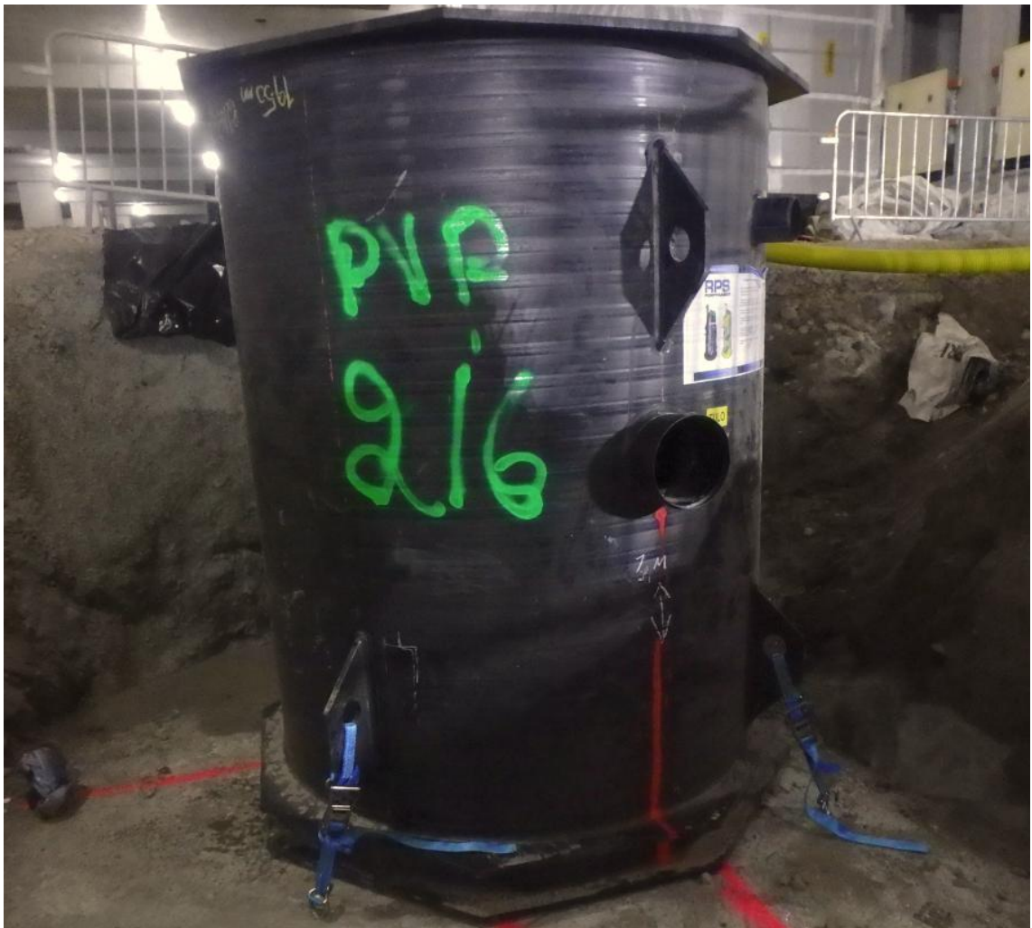
Kuva 4. Perusvesipumppaamo paikallaan ankkuroituna betonianturaan.
