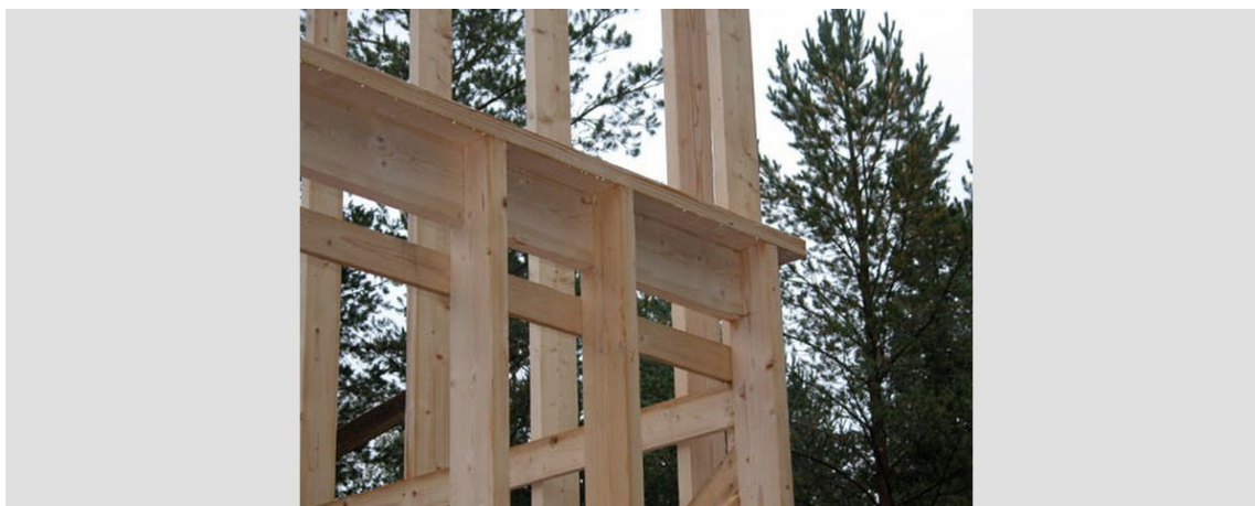
Kuva 5. Lovilankku runkotolppien yläosassa
