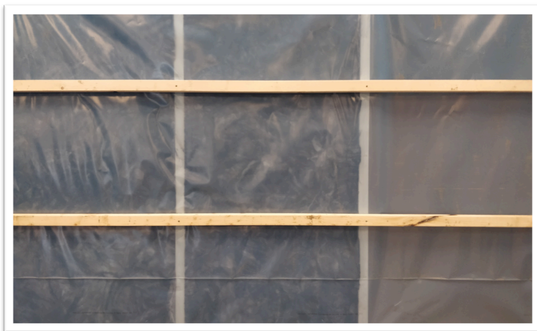
Kuva 13. Malliseinä k900 runkojaolla
