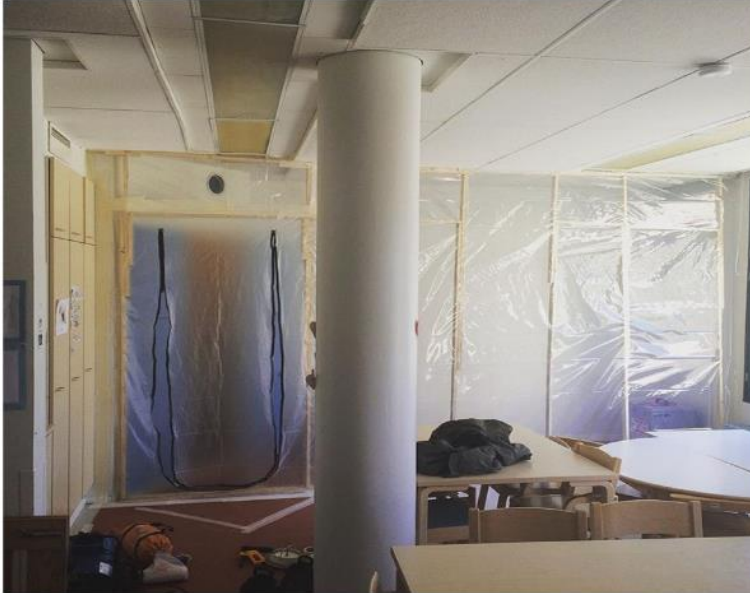
Kuva 14. Kiinteä suojaseinä 22x50mm puurimoilla tehtynä ja vetoketjuovella
