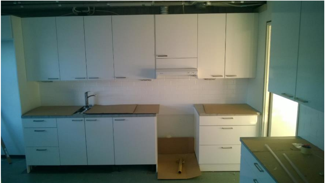
Kuva 11. Keittiön kaapit, vesipiste, tasot ja välitila asennettuna
