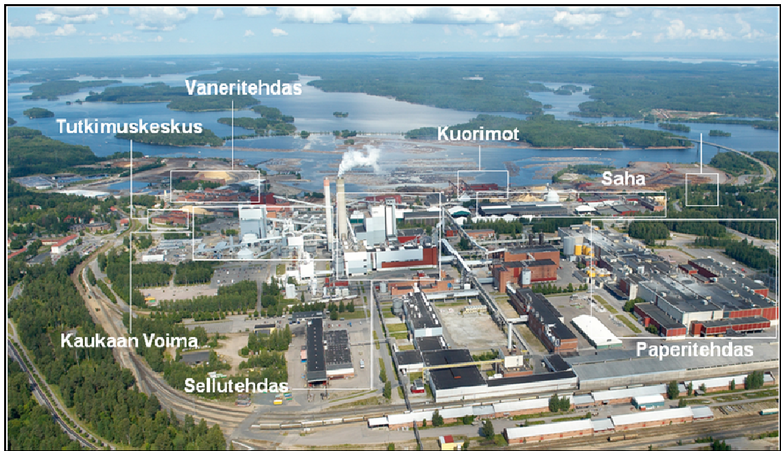
Kuva 2.1 Kaukaan tehdasintegraatti (Kaukaan tehtaat 2010)
