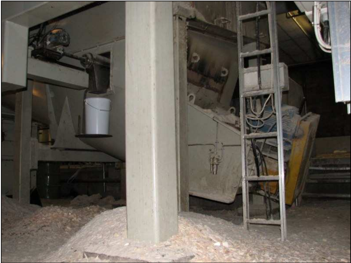
Kuva 5.2 Elevaattorin syöttöruuvi paikallaan
