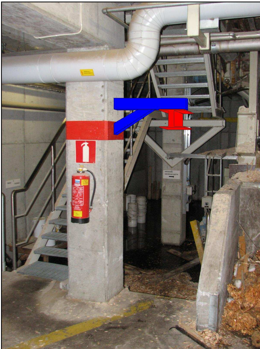
Kuva 5.7 I-palkin asennuspaikka
