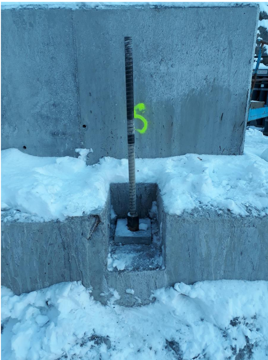
Figur 6. Stag redo att spännas
