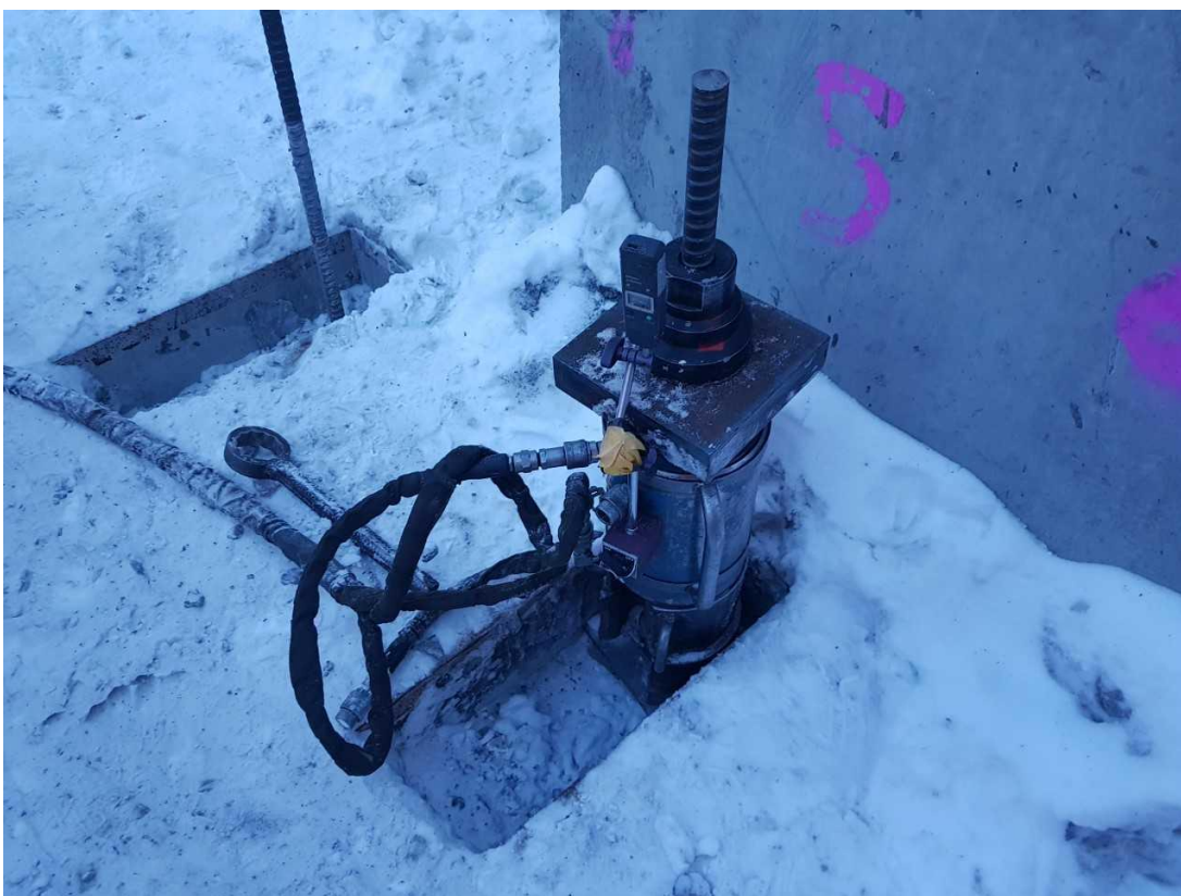
Figur 8. Hydraulisk domkraft på plats redo för uppspanning
