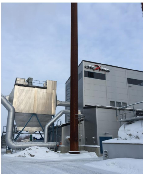
Kuva 5. Kuva sähkösuodattimesta ja Toivalan lämpölaitoksesta.
