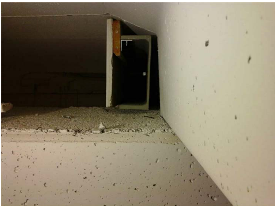
Kuva 37. TT-laattaa on vahvistettu ripaan kiinnitetyllä U-teräksellä.
