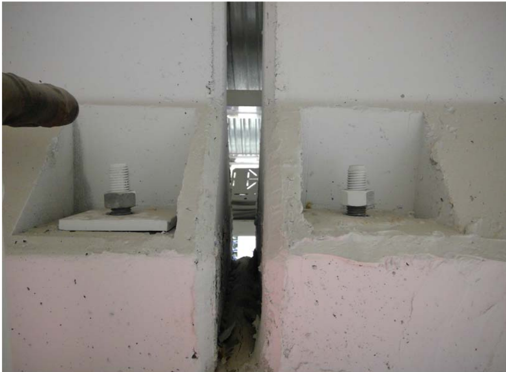
Kuva 21. HI-palkin liitos pilariin kahdella pultilla. Liitoksen mutterit ovat löysällä.
