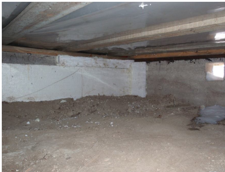
Kuva 1: Alapohja ryömintätalasta kuvattuna
