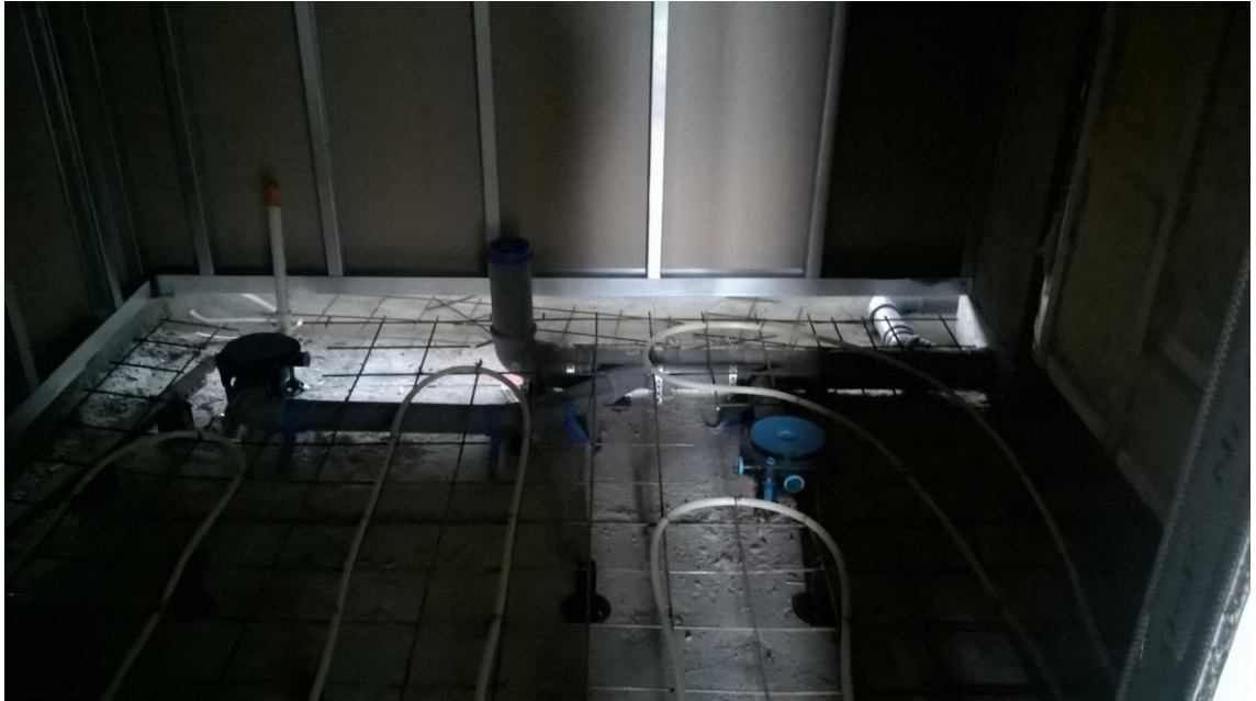
Kuva 7. Sisätyövaiheessa pumpulla valetaan valmiiden seinien sisään. Kuva Marianne Lindberg.
