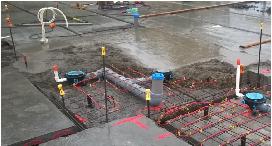
Kuva 5. Kylpyhuoneen kololaattaa valetaan Jassikalla. Kuva Marianne Lindberg.
