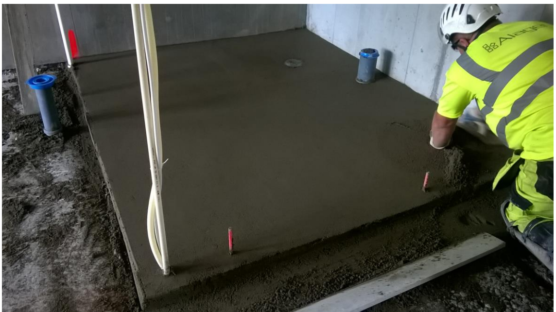
Kuva 10. Yhden kylpyhuoneen lattian valuun kuluu aikaa noin 20 minuuttia. Kuva Mari- anne Lindberg.
