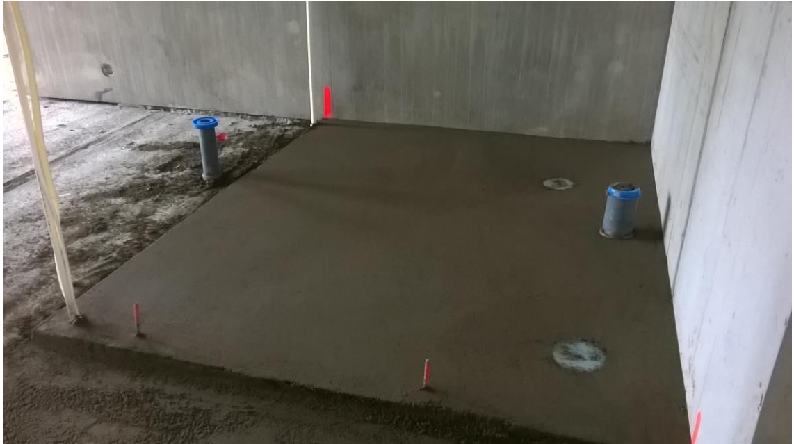
Kuva 11. Valupinta on kolmessa viikossa kuiva vesieristettäväksi. Kuva Marianne Lindberg.
