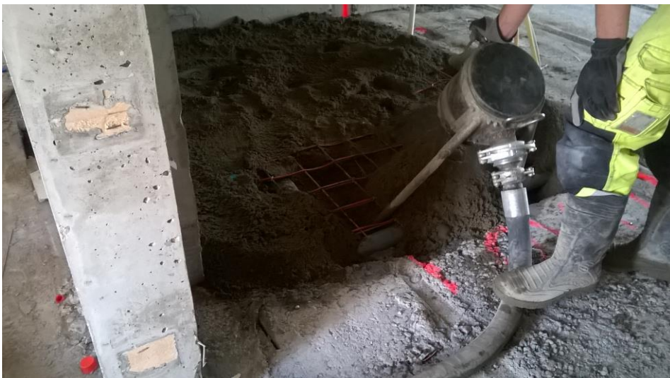
Kuva 9. Maakostea betoni pumpataan betonirekasta kerrokseen. Kuva Marianne Lindberg.
