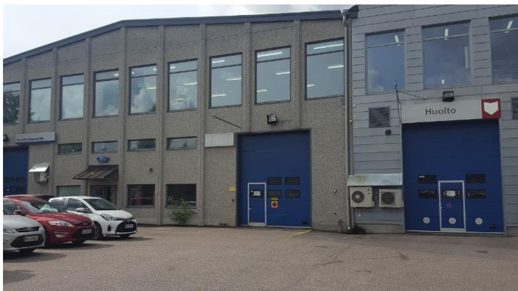
Kuva 12. Huollon sisäänkäynti vasemmasta laidasta
