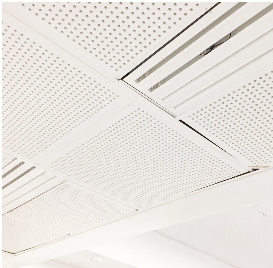
Kuva 9. Takaosan uusitut kattopaneelit
