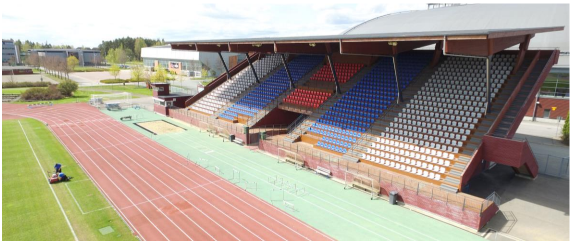
KUVA 2. Mehtimäelle vuonna 2013 valmistunut yleisurheilukentän pääkatsomo kuvattuna kesäkuussa 2017 (Kuva: Joonas Korjonen 2017)
